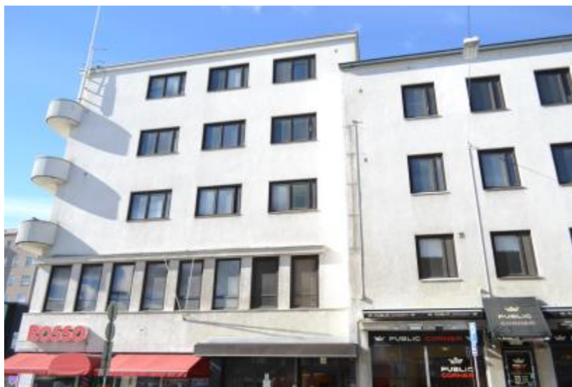
Osuuskaupan talo Sibeliuksenkadulla edustaa linjakasta funkkista. Rakennus on yhä alkuperäiskäytössä.
