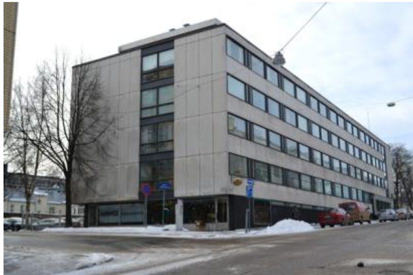
1960-l. alussa valmistuneen asuin- ja liiketalon ajanmukaisia piirteitä ovat nauhaikkunat, sisäänvedetyt katto- ja pohjakerrokset sekä graafinen värimaailma. Hallituskatu 7.
