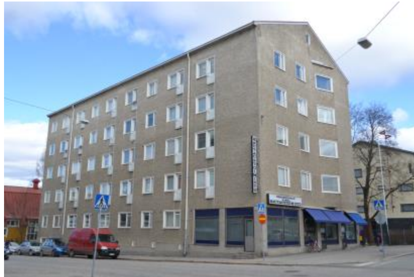
1950-luvun kerrostalon tyypillisiä piirteitä ovat satulakatto, rapattu julkisivu ja eleettömät ikkunat hienovaraisilla erkkereillä. Alakerroksessa on liiketila näyteikkunoineen. Kasarmikatu.
