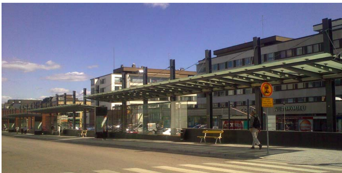
Kuva 23. Jyväskylän keskustan pysäkkiterminaali.
