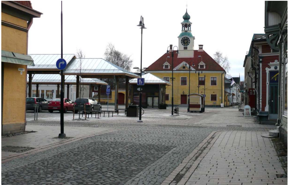
Kuva 19. Esimerkki Shared space -katutilasta Rauman kauppatorilla. Tässä ajorata on erotettu kävelyvyöhykkeestä kolmesta nupukivestä rakennetulla nupukivikourulla jonka perusfunktiona on toimia kuivatuskouruna. Kuva Siton arkisto.
