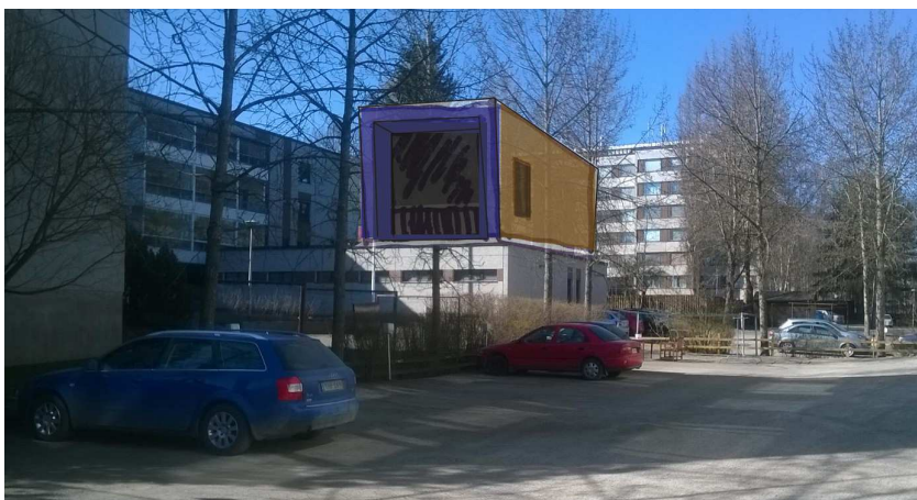
Kuva 22. Kattorakentamismahdollisuus Saaristenkadun pohjoispäässä korttelipihalla.
