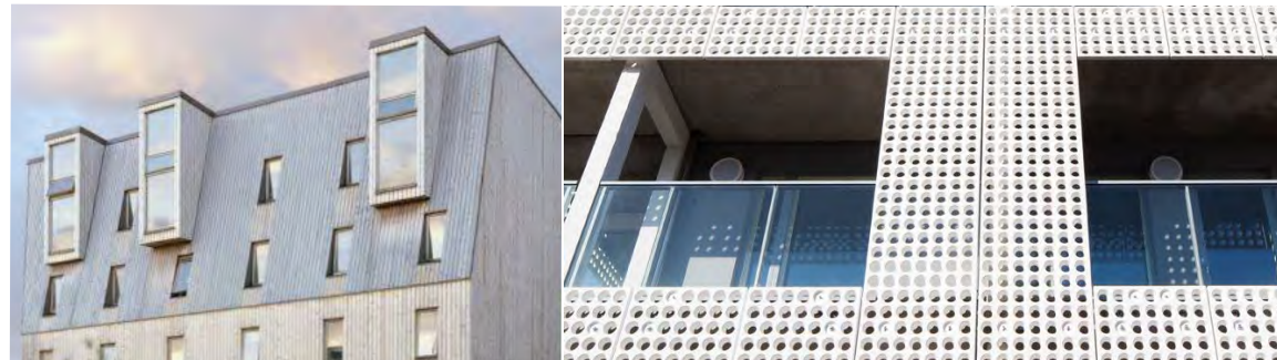
Brendeland&Kristoffersen Architects - Asuinkerrostalo, Trondheim
