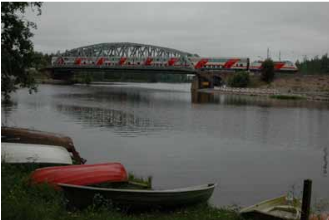
KUVA 91. Pienveneiden maallevetoaluetta puiston pohjoisrannalla. Taustalla rautatiesilta, jonka yli johtaa myös kevyenliikenteen väylä. (Kuva: Sari Saastamoinen, 16.6.2005).
