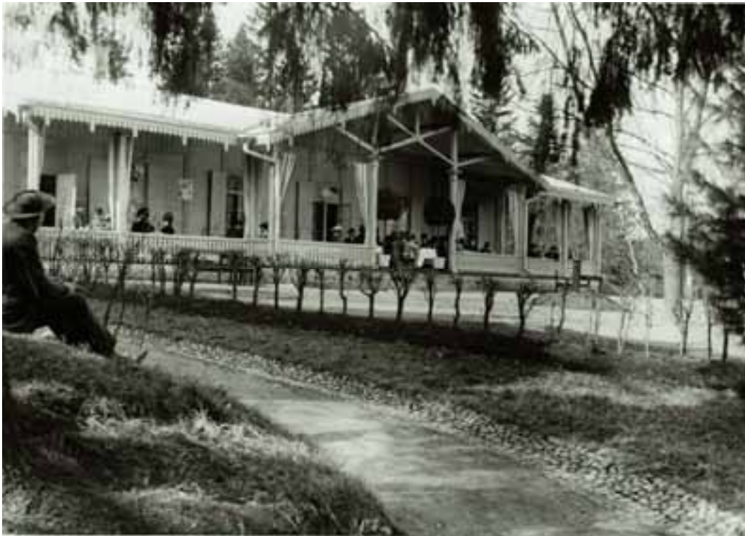
KUVA 64. Puistoravintola arviolta vuonna 1910 (Laitila 1995, 39.) Käytävän reunat on kivetty, terassilla sisäänkäynnin molemmin puolin on astiaistutukset muotoonleikattuine pikku puineen, pihan keskellä on pylväs, jossa aiemmin oli koristeena peilipallo (vrt. KUVA 57). Käytävän reunalla on leikattu pensasaita, kuva on otettu aikaisin keväällä, lehdet eivät ole vielä puhjenneet. (Kuva: HKHMKKA, R1496 III:1).
