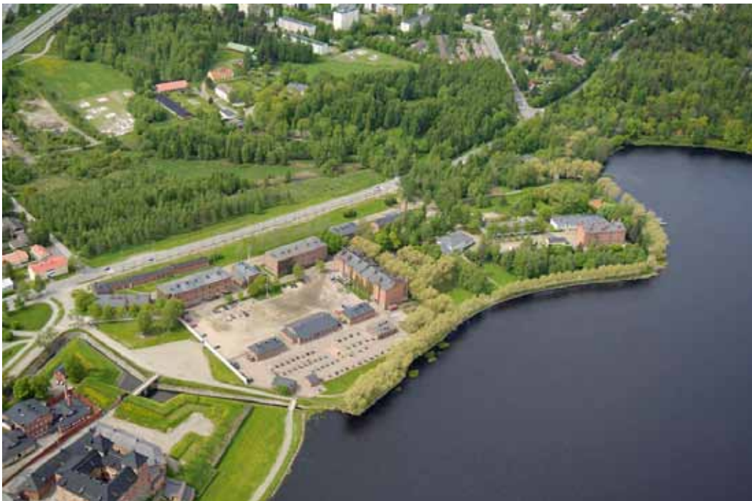
KUVA 15. Ilmakuva Linnan kasarmien alueelta 31.5.2005. Taustalla Ojoisten kartanon alue Tampereentien länsipuolella, oikealla näkyy osa Kaupunginpuistosta. (Kuva: Lentokuva Vallas Oy, LHV 05101/61).
