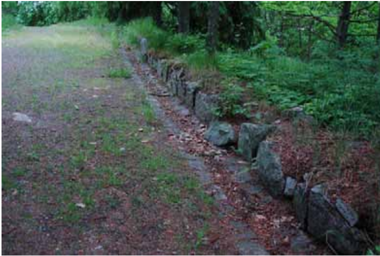
KUVA 34. Puiston etelärinteen käytävän reunan kiveystä ja tukimuuria. (Kuva: Sari Saastamoinen 16.6.2005).
