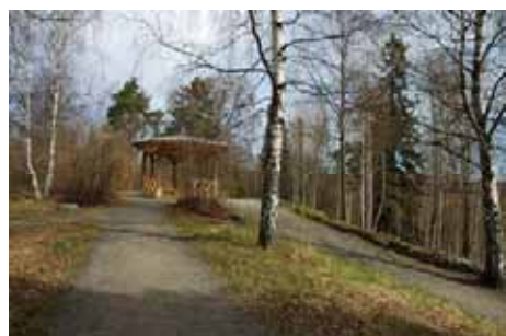
10. kahdeksankulmainen avopaviljonki (uudisrakennus), oikealla tukimuuria
