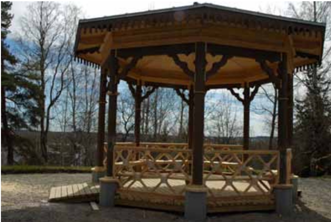
KUVA 99. Umpinaisen vuonna 1988 palaneen paviljongin tilalle rakennettiin vuonna 2005 uusi paviljonki viereisen kahdeksankulmaisen avopaviljongin mallin mukaan. Uusi paviljonki ei kuitenkaan ole tarkka kopio mallista, mm. kaiteen rakenne ja räystäään koristelu on hieman erilainen. (Kuva: Sari Saastamoinen, 16.6.2005).
