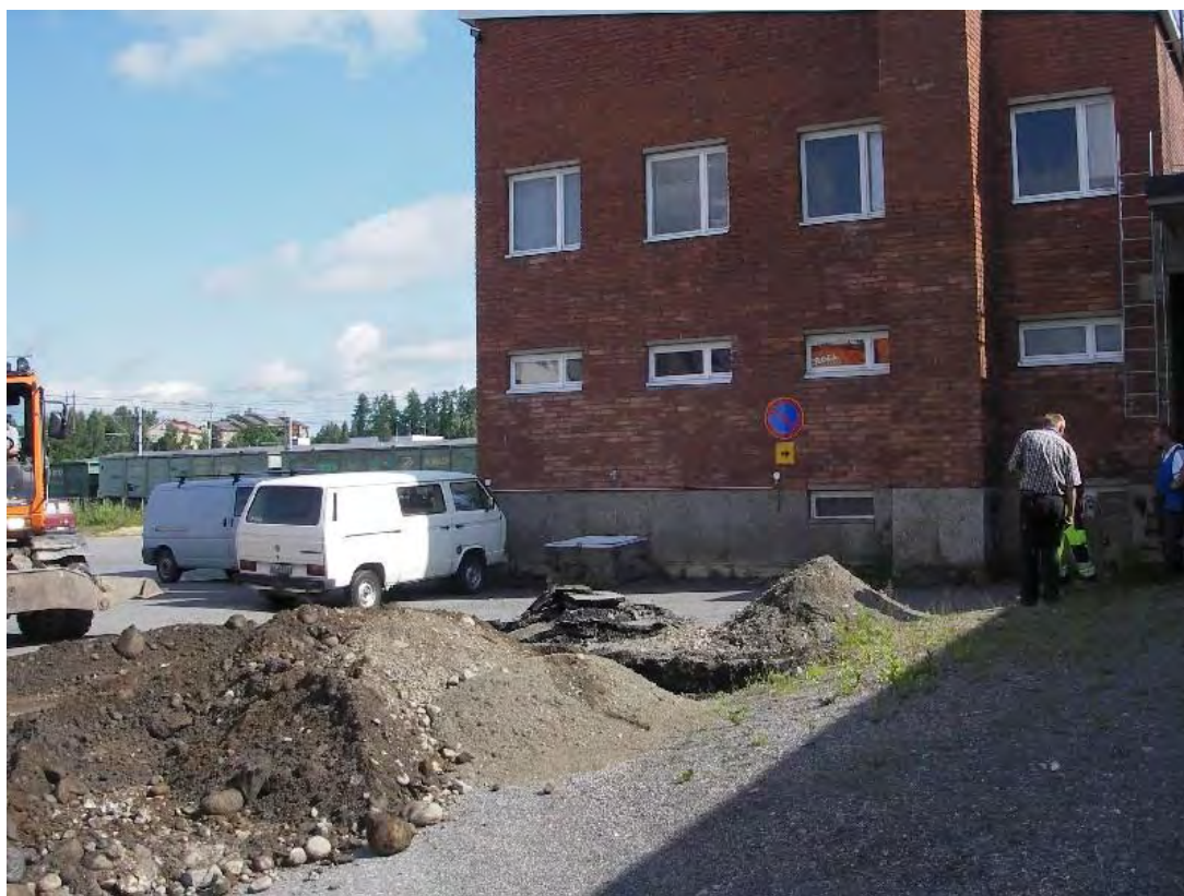
Kuva 2. Entisen tavara-aseman edustalle tehty koekuoppa KK31, jonka alueella todettiin lämmitysöljysäiliö ja maaperässä alemman ohjearvon ylittävä öljyhiilivetypitoisuus.
