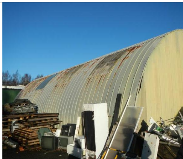
Kuva 18. Yleiskuvaa rakennuksesta nro 18.
