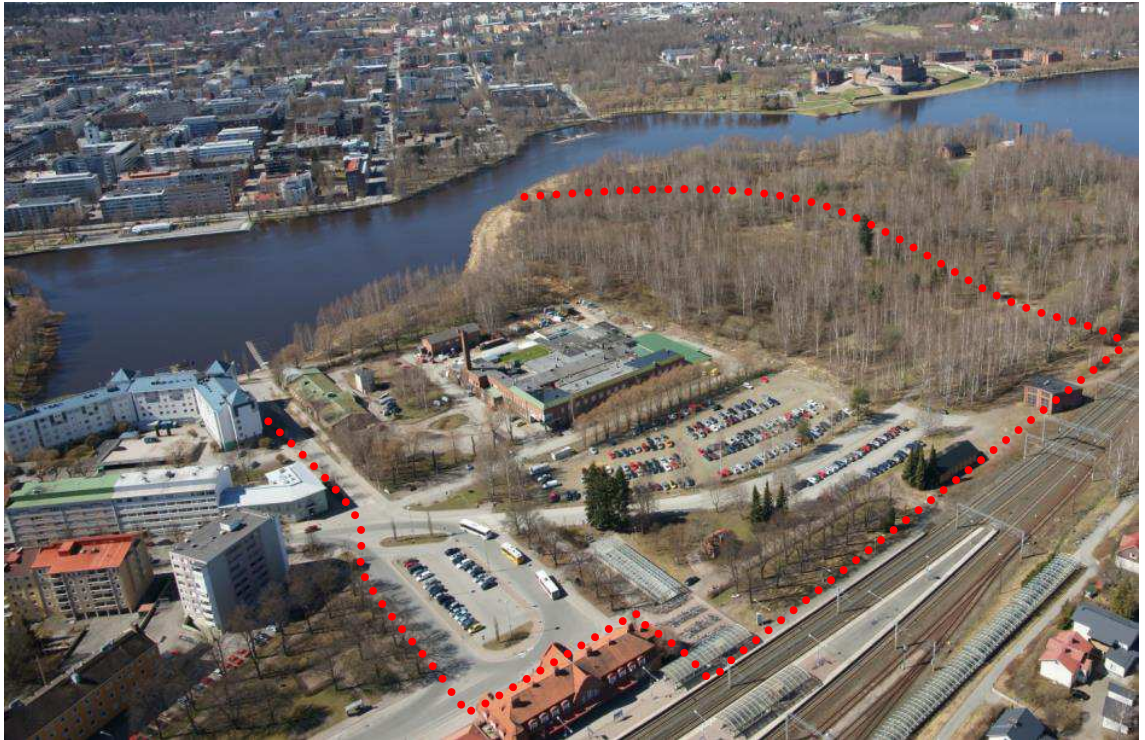
Kuva 9. Ilmakuva alueesta (Lentokuva Vallas, 2013), arkkitehtikutsukilpailun likimääräinen raja- ja punaisella pisteviivalla.
