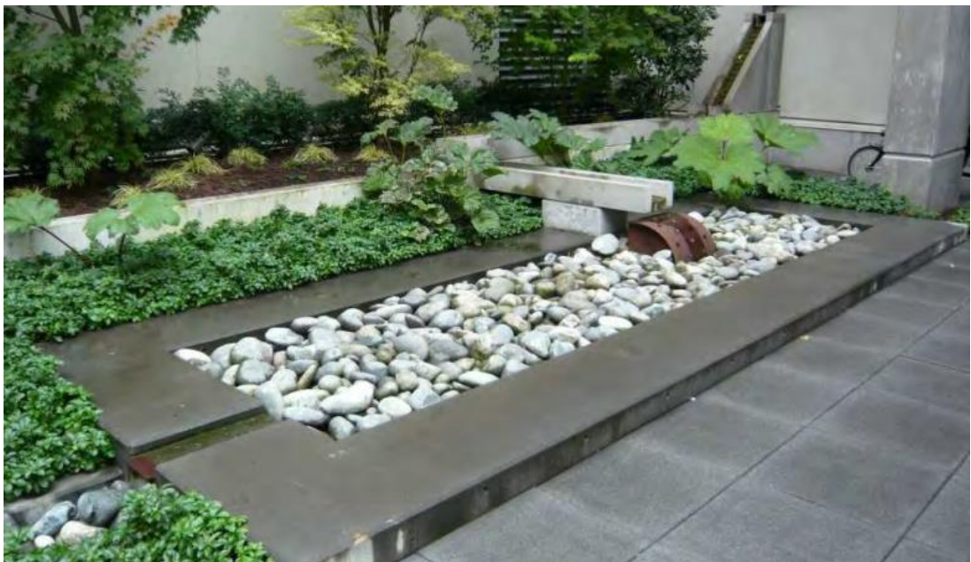
Kuva 11. Kattovedet voidaan johtaa pihatasosta korotettuihin altaisiin
