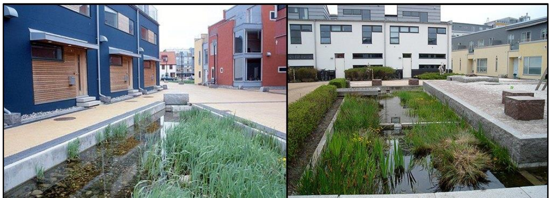
Kuva 14. Tiiviit pohjarakenteet altaissa mahdollistavat myös näkyvän vesipinnan.
