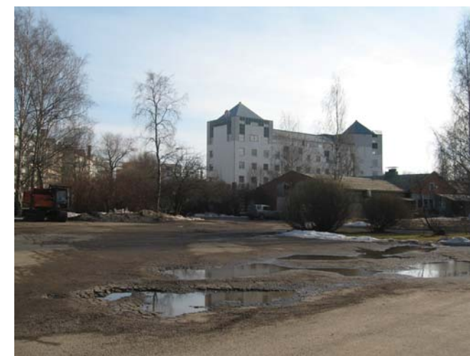
Rannan hotellirakennus vaikuttaa nykyisellään hieman irralliselta. Possentien uusi 5-kerroksinen kortteli sopii hotellin mittakaavaan jättäen silti näkyviin rakennukselle tunnusomaiset torniaiheet.
