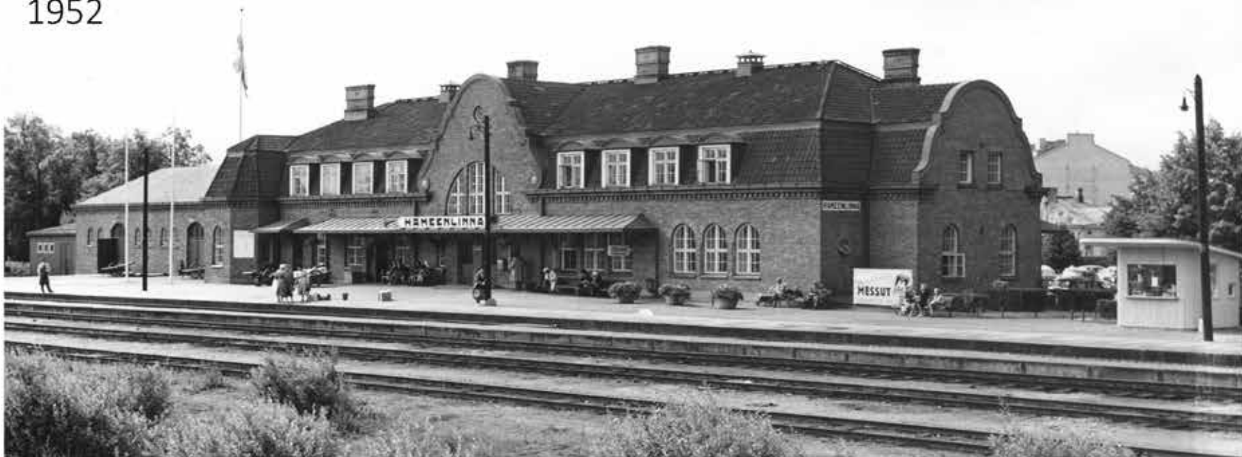
Laiturilla kioski, kukkauurnat, katoksessa ammpelit ja päädyssä leikatut pensasaidat ja vartetut pensaat. Kuvat SRMA
