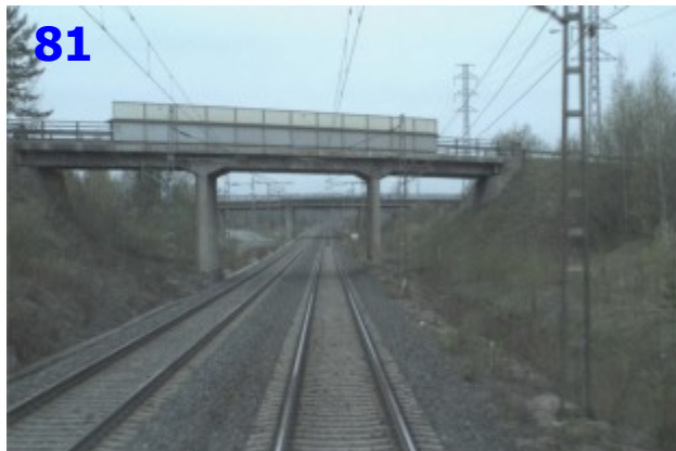
Kuva 81. Kirtstulan ylikulkusilta, km 111+042, pohjoiseen.
