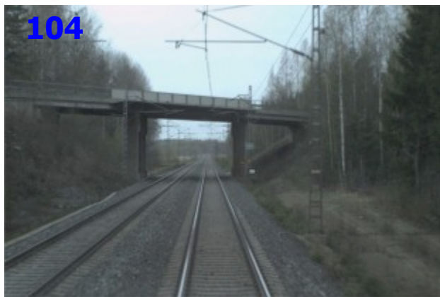
Kuva 104. Iittalan yks, km 126+914, pohjoiseen.
