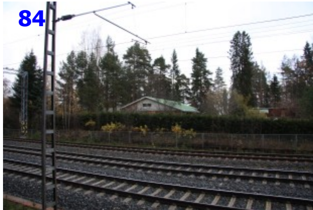
Kuva 84. Asuinrakennus, itäpuoli km 115+150.
