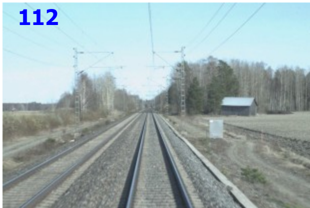
Kuva 112. Maatalousrakennus, km 124+404, etelään.
