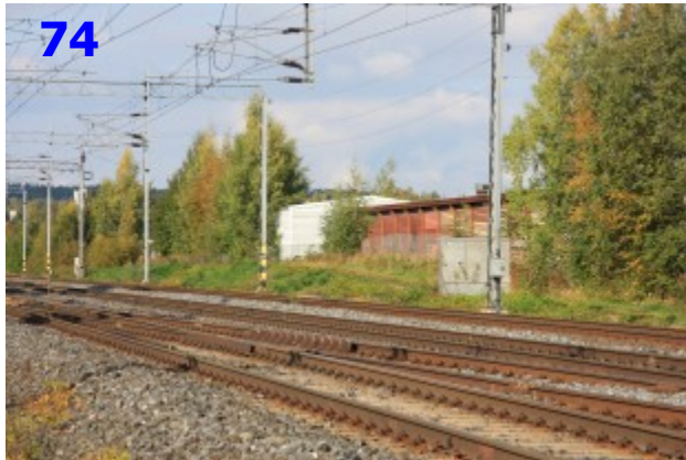
Kuva 74. Varastohalleja, itäpuoli km 106+100, pohjoiseen.
