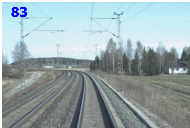
Kuva 83. Asuinrakennus, länsipuoli km 112+696, etelään.
