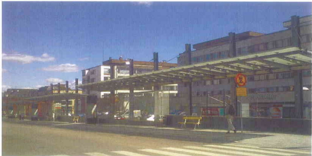
Kuva 23. Jyväskylän keskustan pysäkkiterminaali.
