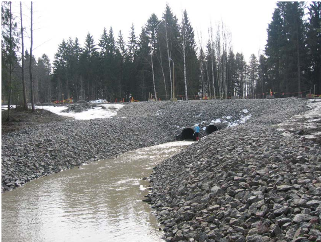
Kuva 12. Vesiympäristön rakentaminen on haastavaa. Myllyojan ylittävän Sammonntien viimeistelytyöiden yhteydessä nyt monotonisiin ojaluiskiin ja -pohjaan pyritään tuomaan vaihtelevuutta isommilla kivillä.
