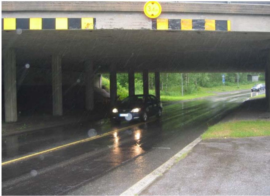
Kuva 6. Vesi kertyy ajoittain Lahdensivuntien moottoritien alituksen kohtaan. Ympäristötoimi 18.6.2008.
