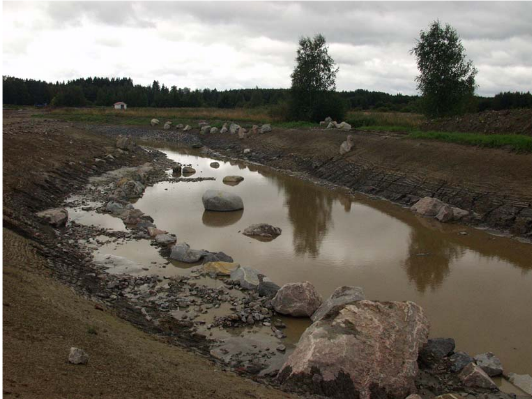
Kuva 8. Sammonojan yksi kosteikkolevennys heti rakentamisen jälkeen kesällä 2008. Susanna Lappalainen.
