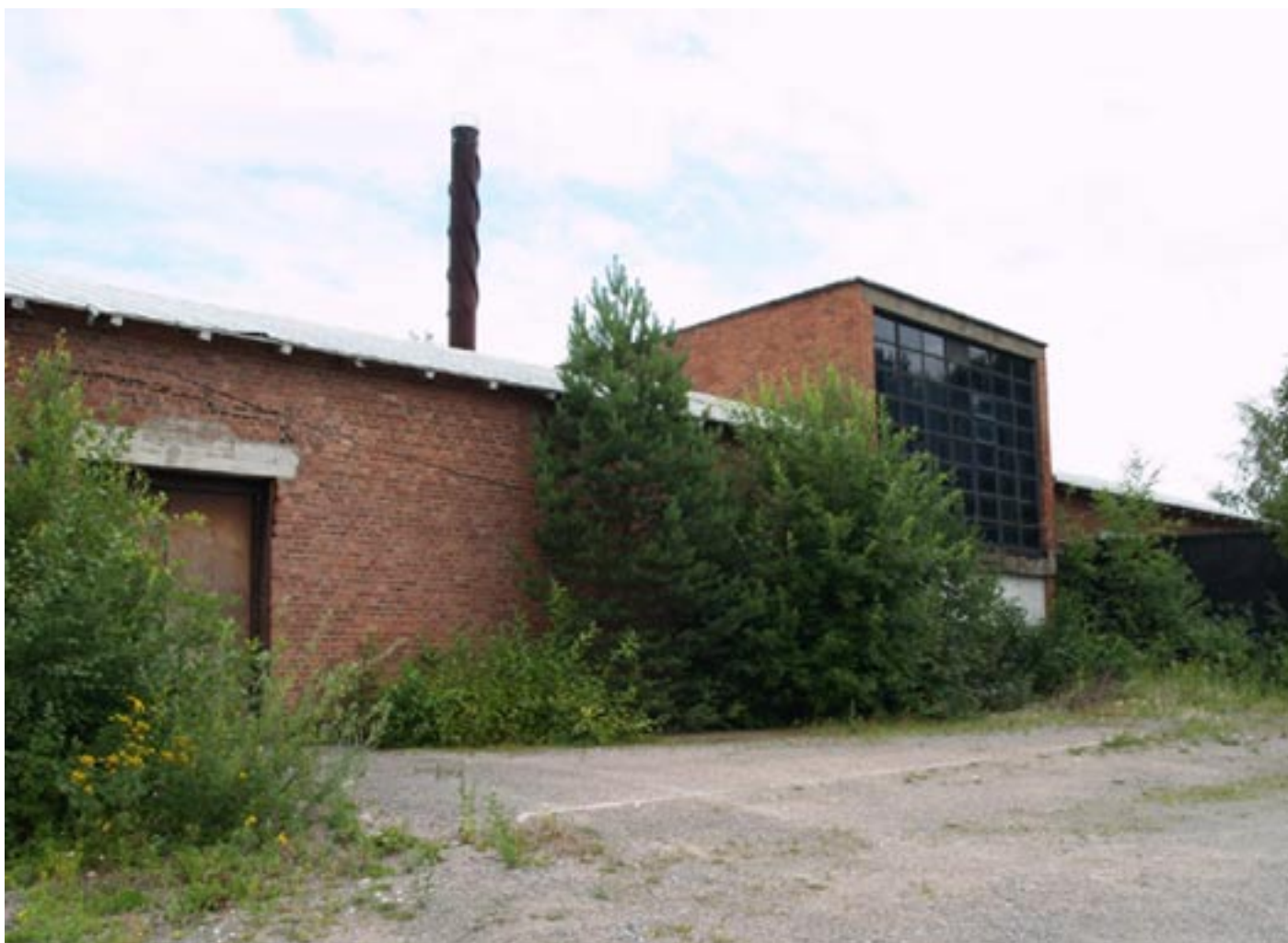
Teurastamo tänään. Vanajantien puoleista julkisivua hallitsee tuuletushallin suuri ikkunapäätty.
