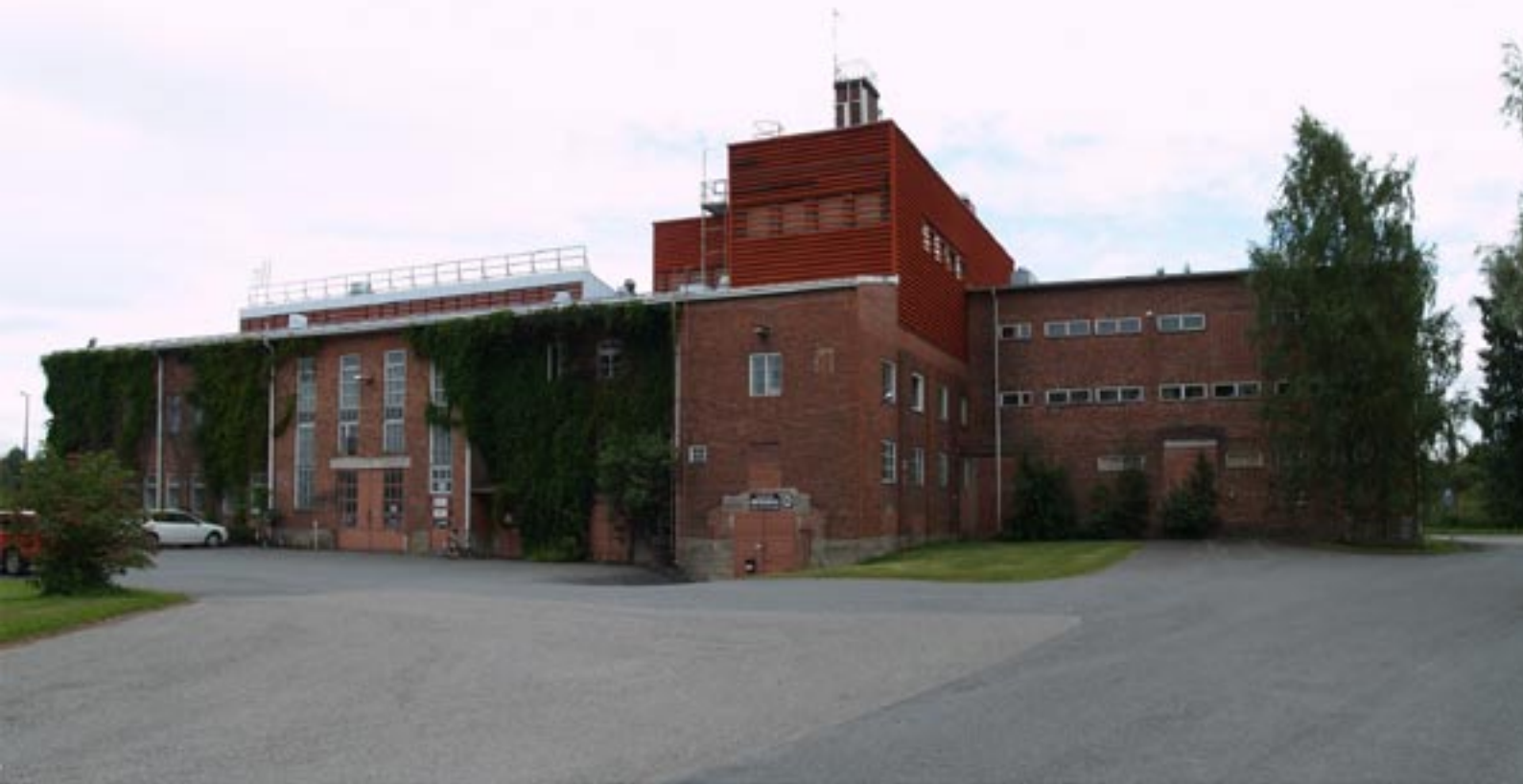
Entisen perunajauhotehtaan Vanajantien puoleinen julkisivu.
