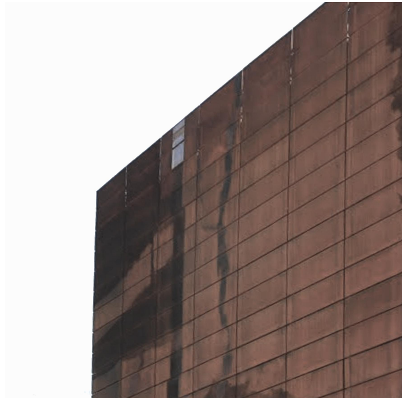
PÄÄJULKISIVUJEN PARVEKKEIDEN PINTAMATERIAALINA RUSKEA PERFOROITU METALLILEVY
