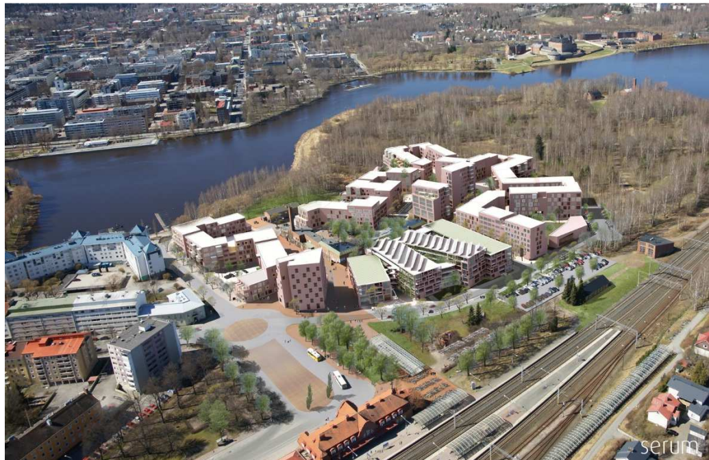
Kuva 39. Uudisrakentaminen muodostaa selkeän uuden rajauksen valtakunnallisesti merkittävälle rautatieympäristölle. Kaavaratkaisu on kaupunkikuvallisesti jäntevä ja verrattavissa Kiistalan alueen rakentamistapaan (Serum Arkkitehdit Oy, 2016).
