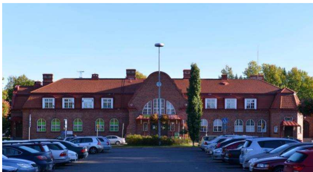
Kuva 6. Hämeenlinnan rautatieasema, 1921. Tiilinen asemarakennus on harvinaista 1920-luvun barokkivaikutteista klassismia edustavaa tyyppiä.
