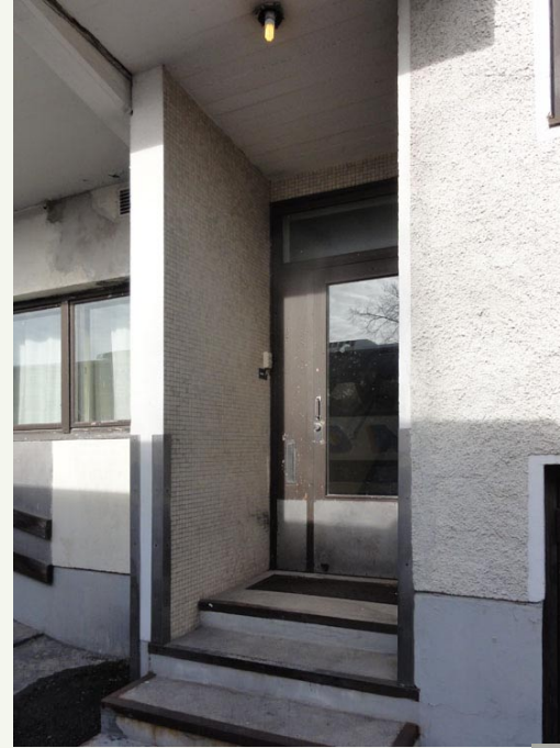
Lastauslaiturin vierestä on sisäänkäynti ravintolan keittiötiloihin sekä asuntoihin.
