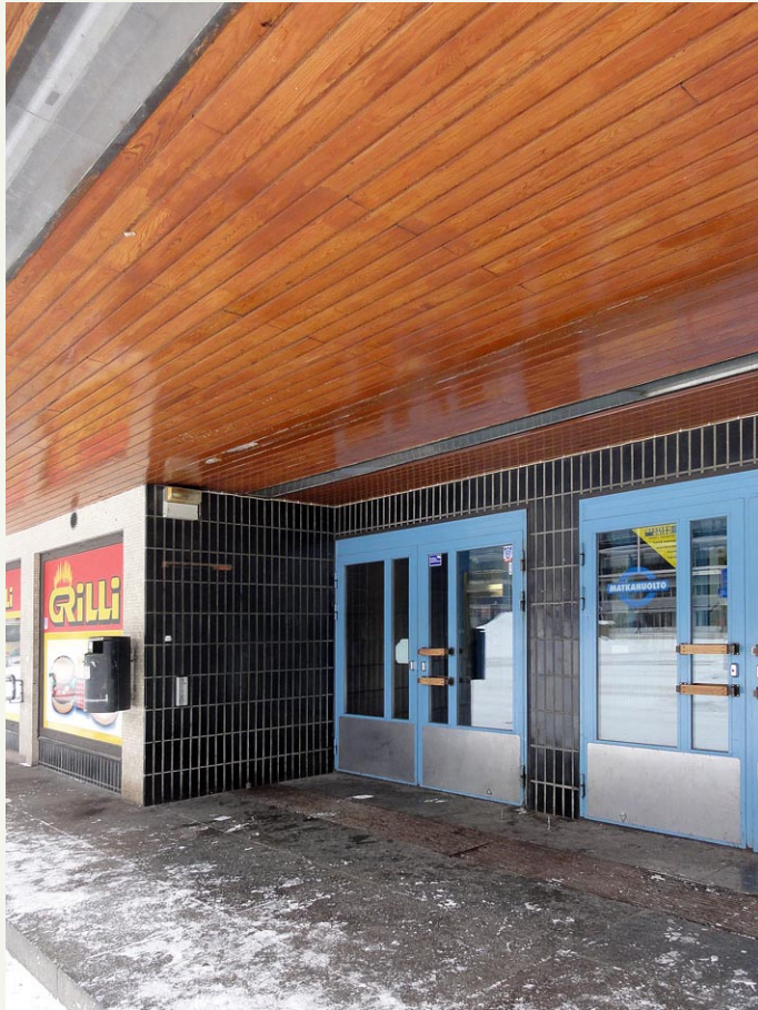
Pääsisäänkäynnin pintamateriaaleja: lakattua puukattoa, jossa upotettu valovyöhyke, seinien mustaa klinkkerisauvaa ja uudet teräsovet.
