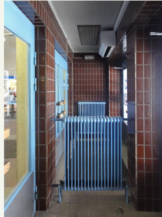
Tuulikaapissa klinkkeriseinät ovat ruskeasävyiset, lattian pinta on harmaata laattaa. Valurautapatterit on maalattu samalla sinisellä kuin teräsovet.
