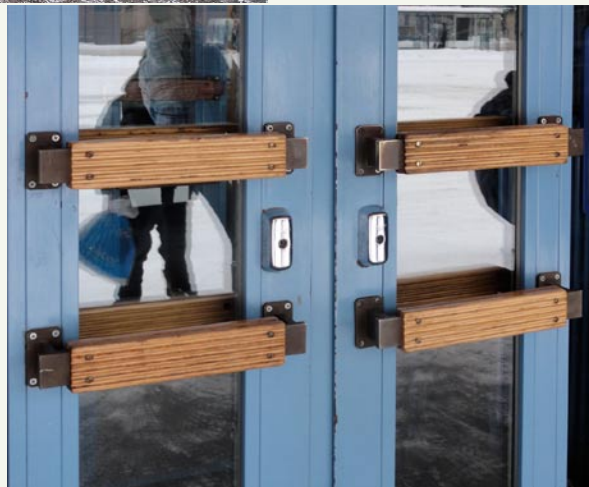
Pääovien ovenvetimet ovat uurrettua puuta.
