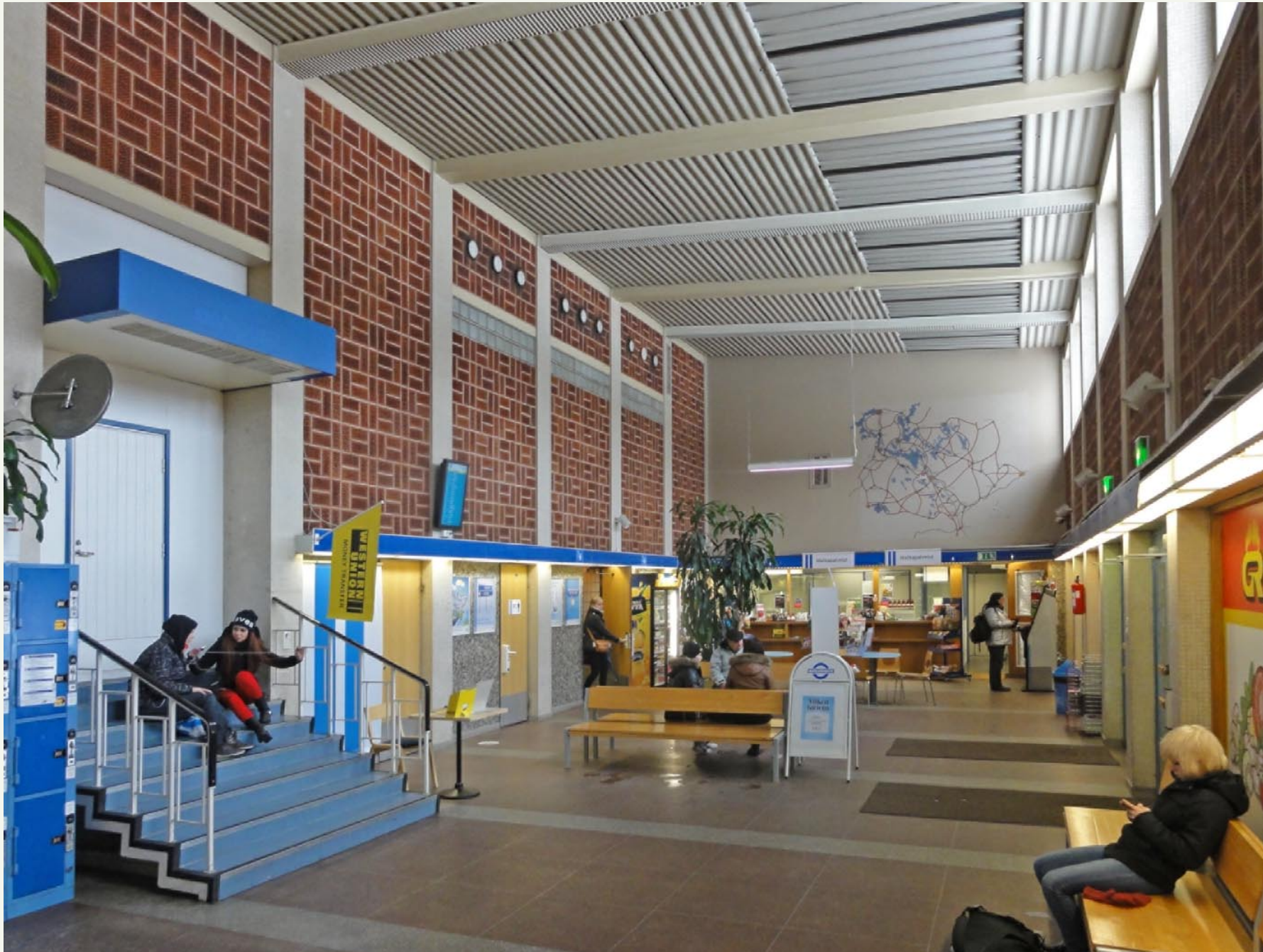
Näkymä keskushalliin, vasemmalla portaat ravintolatalaan, taustaseinällä matkailukartta. Hallin seinien alaosat ovat mosaiikkipintaiset, katossa profililevyä. Katon palkeista joka toiseen on upotettu valaisinvyöhykkeet. Lattian pintamateriaalina on niin ikään alkuperäinen sementtimosaiikki, jossa on vyöhykejako.
