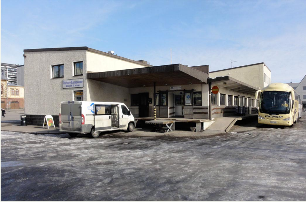
Länsipään lastauslaiturin katoksessa on alkuperäinen poimutettu kuparilevyverhous.
