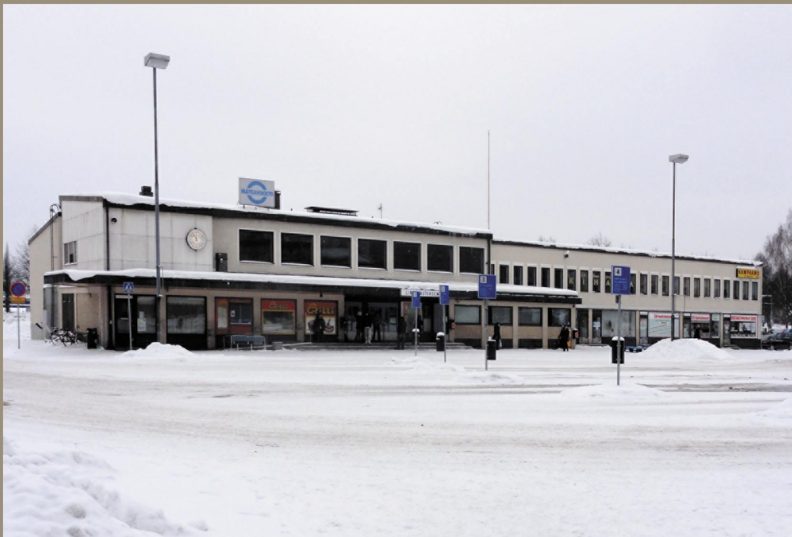
HÄMEENLINNAN LINJA-AUTOASEMA RAKENNUSHISTORIALLINEN SELVITYS Tmi Lauri Putkonen 23.3.2012
