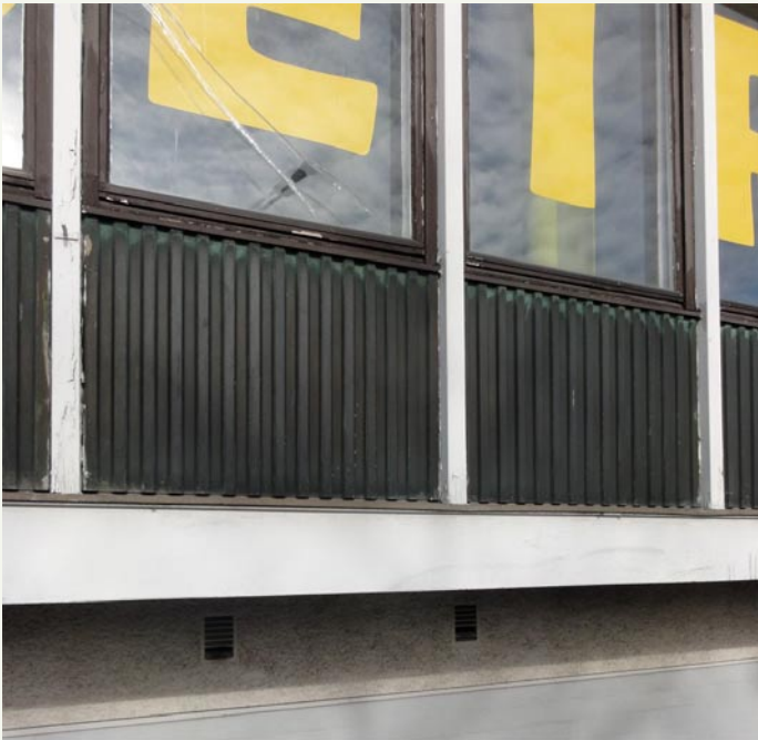
Alkuperäistä kuparilevyverhousta entisen ravintolasalin julkisivussa.
