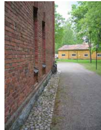
Olemassa olevan asuinrakennuksen (28) seinänvierustan kenttäkiveystä alueelta.
