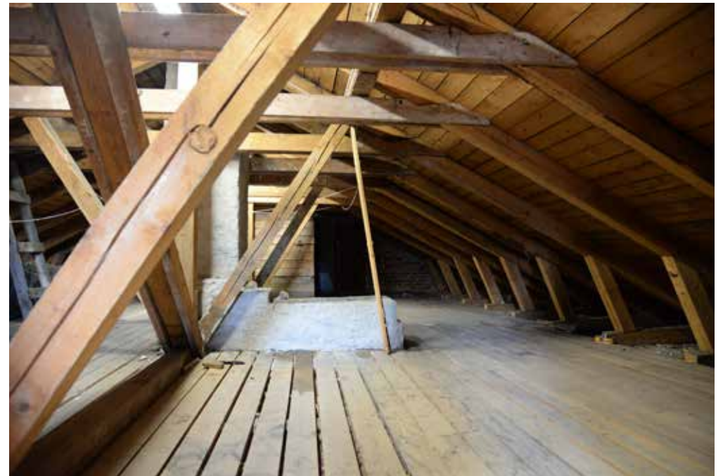
Kylmä vinttitila. Käynti asemapäällikön asunnosta.
