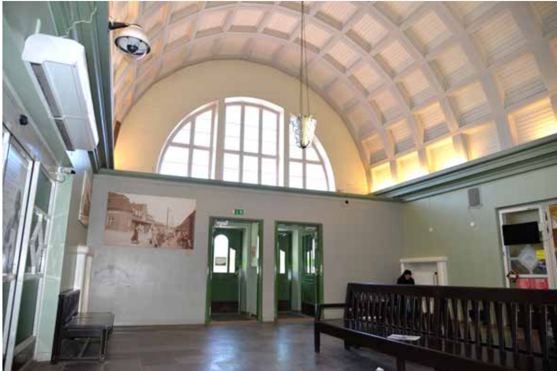
Keskushalli aukiolle päin. Kasettikatto ja kalkkikivilaatat (44 x 44 cm).
