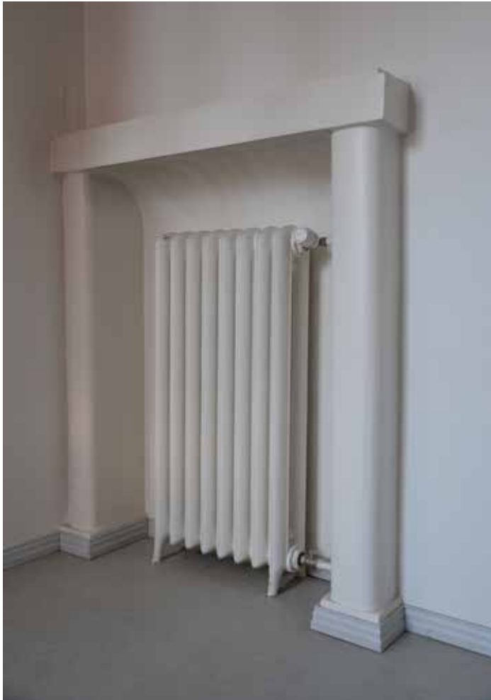
Toimistuhuoneen patterisyvennys. Odotushuoneen ovet toimistoon. Jatko-osassa vanha pääty ovi on jäänyt rakenteiden sisään.
