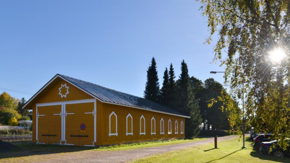
11. VR:n omistuksessa oleva lautarakenteinen vaunuvaja, 1860-luku (rautatieaseman I-rakennusvaihe) Nykyisin toimii tavaravarastona. Vaunuvaja on ainoa säilynyt 1860-luvun vaunuvaja.
