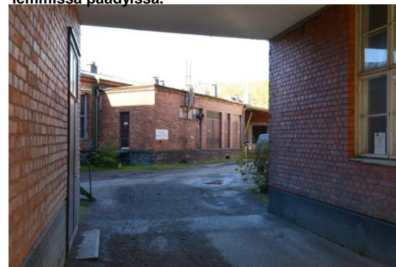
2-III Mensa Oy:n tehdasrakennus, sisäpihan laajennuksia, rakennusvaihe III
