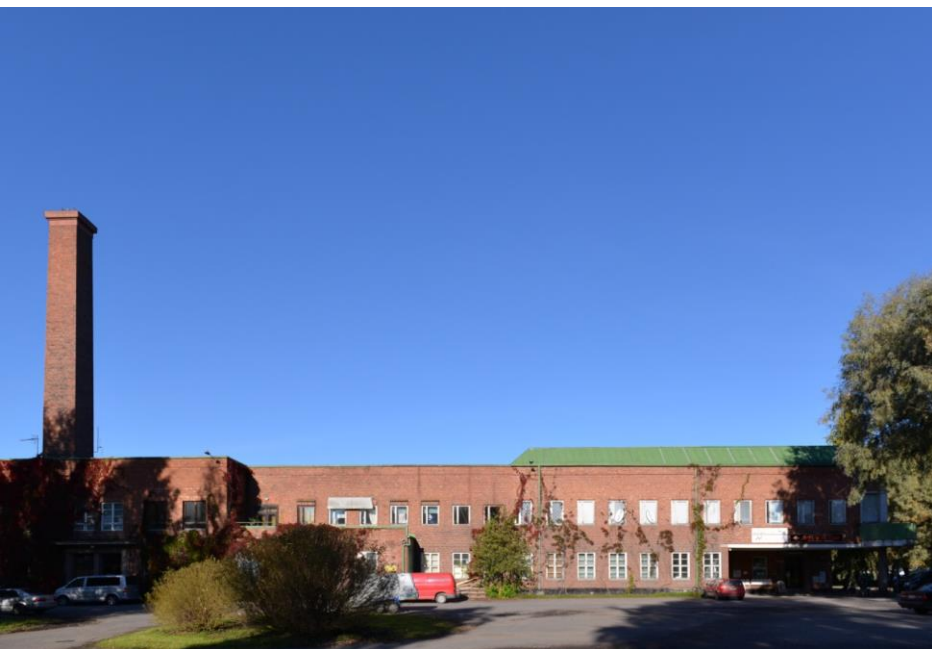
2. Mensa Oy:n vanha tehdasrakennus, rakennusvaihe III. Julkisivu kaakkoon.
