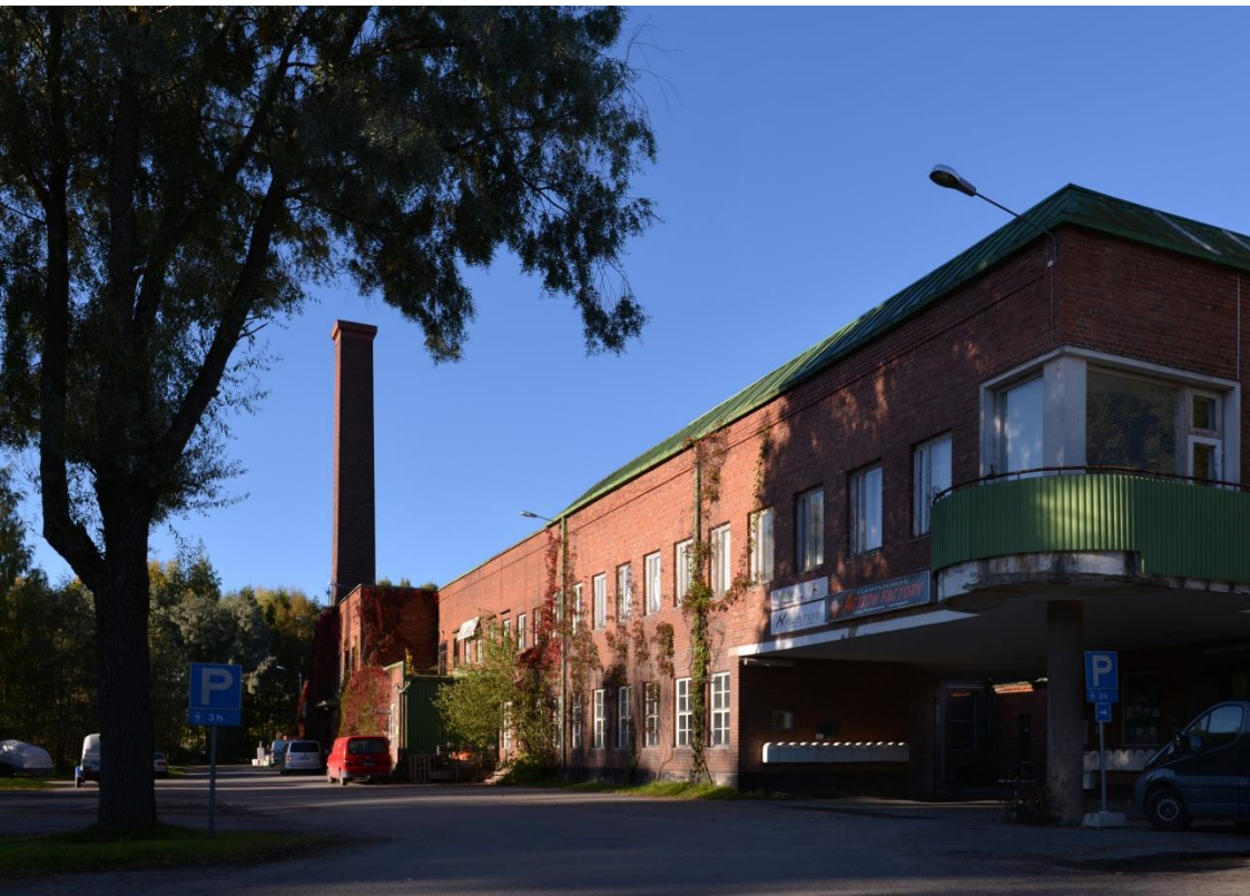
2-III. Mensa Oy:n vanha tehdasrakennus, rakennusvaihe III. Julkisivu kaakkoon.
