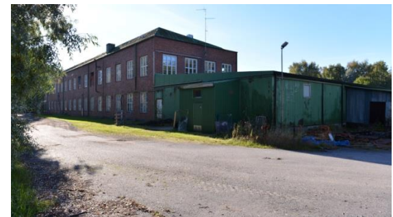
3. Mensa Oy:n vanha tehdasrakennus, kuva lounaasta
