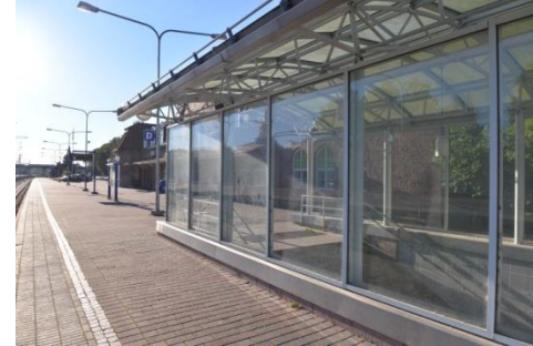
14. Asemalaiturin katos alikulkutunneliin
