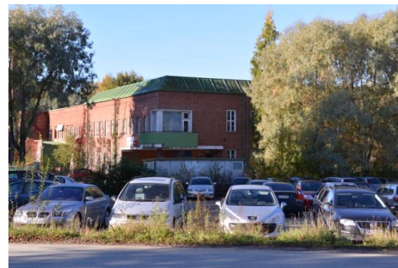
2-IV. Tehdasrakennus luoteesta, rakennusvaihe IV
