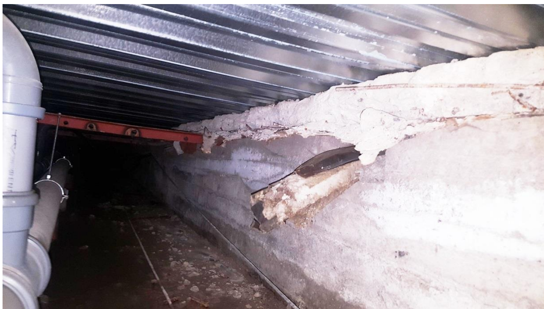
Kuva 1. Putkikanaali käytävän 301a/b suuntaan kuvattuna
