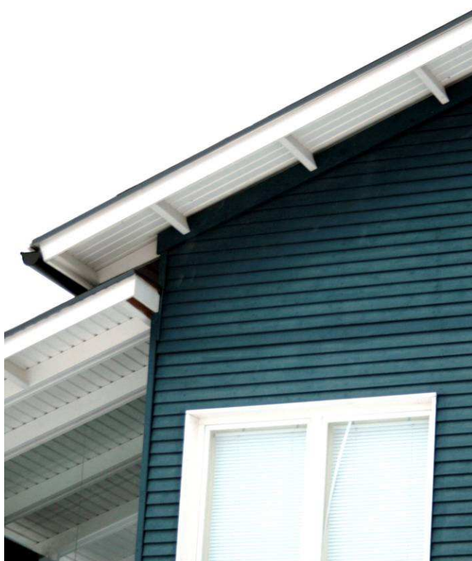
Kuva 5: Esimerkki ohuista ikkunan puitteista, avoräystäästä ja julkisivulaudoituksesta.
