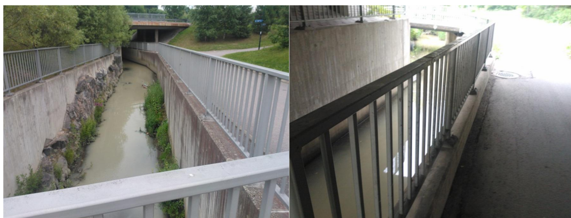
Kuva 7.1 Esimerkki alikulun yhteydessä toteutetusta Espoon Monikonpuron rakennetusta uomaosuudesta Kehä I:n ja Perkkäntien alituksessa (© Kimmo Hell, Ramboll Finland Oy).
