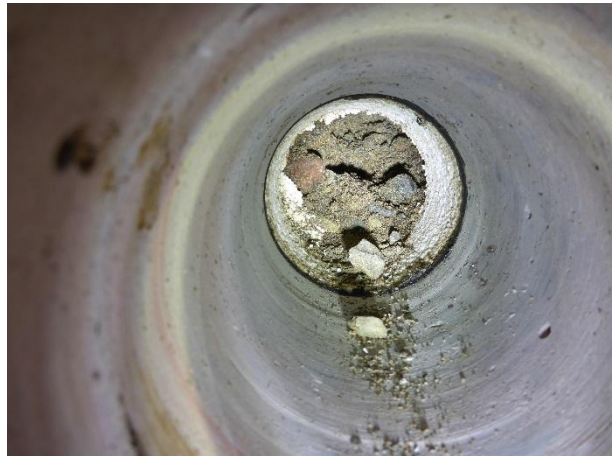
Kuva 4. Levyn takana on hienojakoinen soratäyttö, joka tutkimushetkellä oli kostea.
