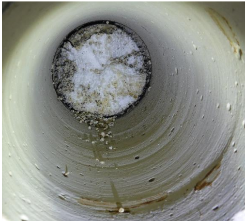
Kuva 3. PM-1 rakenteen ulkopinnassa on kuiva EPS-levy
