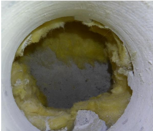
Kuva 5. PM-2 rakenne on toteutettu jostain syystä mineraalivillaeristeisenä
