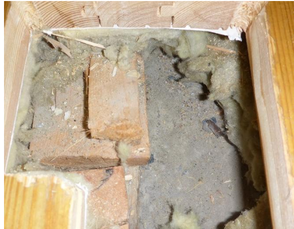
Kuva 2. Höyrynsulkumuovina on käytetty vahvaa PE-kalvoa
