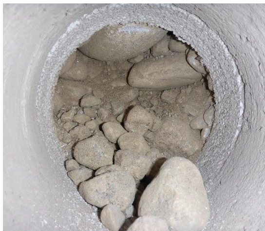
Kuva 3. Pohjoispuolen pitkän sivun täyttömateriaali on seulomatonta soraa, jossa hienoainepitoisuus on suuri
