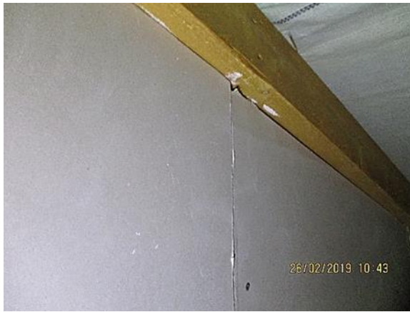
Kuva 35. Palokatkoalevytyksen asennus katto- ja seinäristikon alapintaan
