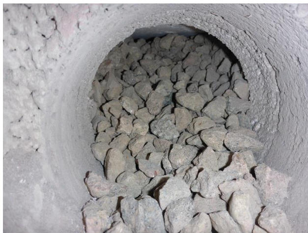
Kuva 4. Itäpäädyssä täyttömateriaali on seulottua sepeä 8-16
