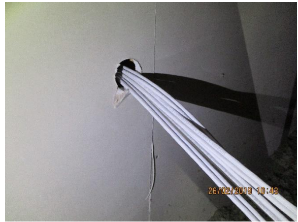
Kuva 36. Palokatkoalevyyn tehdyn läpivientin yksityiskohta
