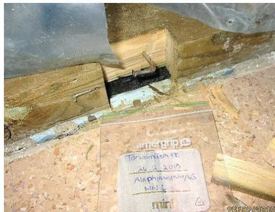
Kuva 9. Rakenneavaus ulkoseinärakenteeseen
