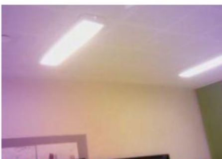
Kuva 23. Tavallinen kuva lämpökuvausalueelta
