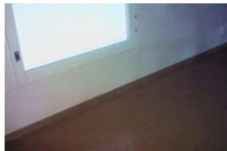
Kuva 15. Tavallinen kuva lämpökuvaualueita
