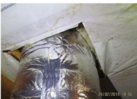
Kuva 34. Höyrnsulku on asennettu yläpohjaan epätiivisti, ja sen saa poistettua vain nostamalla. Näin ei kuuluisi olla.
