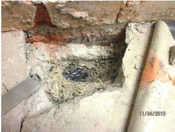
Kuva 25. Alapohjarakenteena on lämmöneristetty kaksoisbetonilaatta. Väliseinä tukeutuu pohjalaattaan. Väliseinän ja pohjalaatan välissä on bitumisively.
