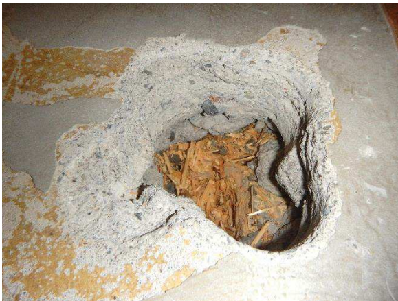
Kuva 146. Välipohja on kotelolaattarakenteinen. Uudemman lattiatasoiheen alla havaittiin jäämiä vanhan lattiapäällysteen kiinnitysliimasta.
