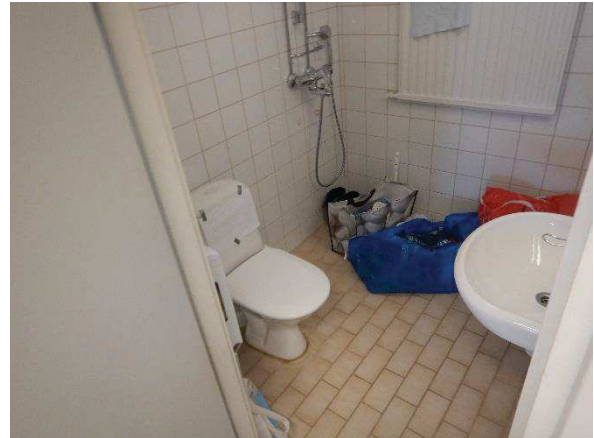
Kuva 170. Yleiskuva ensimmäisen kerroksen kylpyhuoneen A116 pintamateriaaleista. Pintarakenteet ovat peräisin 1980- tai 1990-luvulta ja niiden yleiskunto on tyydyttävä.
