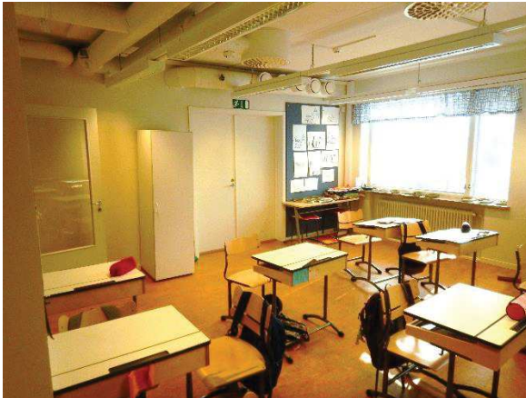
Kuva 169. Yleiskuva toisen kerroksen luokkatilan A212 pintamateriaaleista. Pintarakenteet ovat pääosin 2010-luvulla uusittuja ja niiden yleiskunto on hyvä. Etenkin ulkoseinien pintarakenteissa on pienimuotoisia paikallisia kosteusvauriojälkiä.
