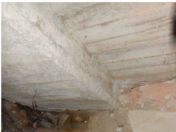
Kuva 163. Rakenneavauskohdan ympärillä oleva seinärakenne ryömintätilan puolelta kuvattuna. Ympäröivä seinärakenne eroaa rakenneavauskohdan rakenteesta. Ulkokuori on betonirakenteinen ja sen sisätilojen puoleisessa pinnassa on bitumisively.
