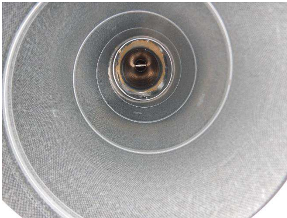
Kuva 214. Tuloilman kanavistossa ei havaittu näkyvää likaa tai pölyä.
