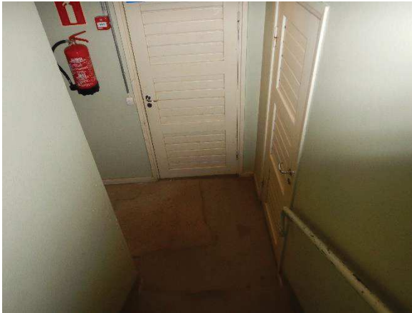
Kuva 154. Yleiskuva kellarin aulatilan A001 väliseinistä.
