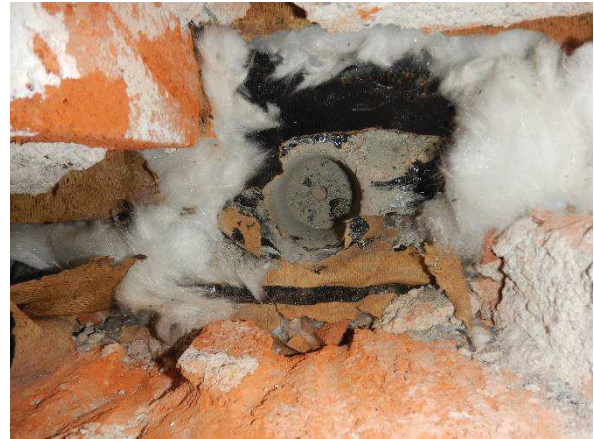
Kuva 63. Bitumisively on yhtenäinen ja tiivis.
