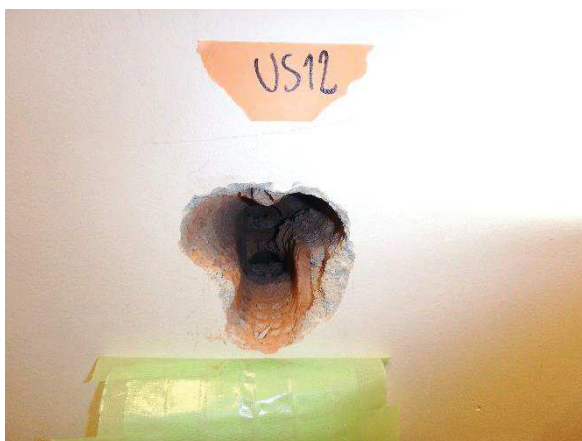
Kuva 113. Ulkoseinä on massiivitiilirakenteinen.
