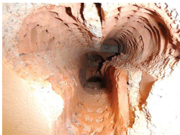
Kuva 114. Rakenteessa ei havaittu erillistä lämmöneristekerrosta.
