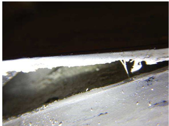
Kuva 36. Viiltomittaus VM4. Muovimaton kiinnitysliimassa ja lattiatasoiteessa ei havaittu aistinvaraisesti arvioituna viitteitä vaurioitumisesta.
