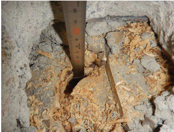
Kuva 132. Välipohja on kotelolaattarakenteinen.
