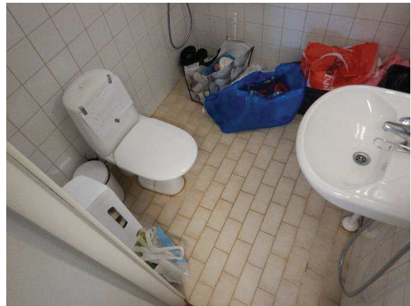
Kuva 9. Yleiskuva ryömintätalallisen alapohjan lattialaattapäällysteestä kylpyhuoneesta A116.
