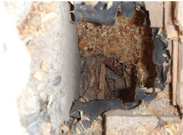
Kuva 144. Välipohjan betonipalkin korkeudeksi mitat-tiin noin 280 mm.
