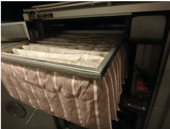
Kuva 204. Tuloilman F7-luokan pussisuodattimet olivat tarkastushetkellä puhtaita.
