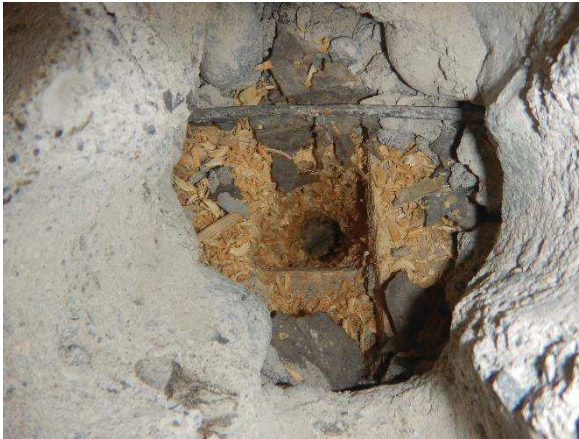
Kuva 138. Välipohja on kotelolaattarakenteinen.
