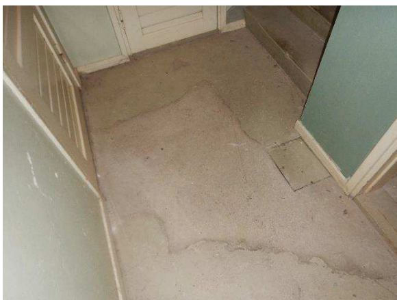
Kuva 2. Yleiskuva maalipintaista maanvaraisesta alapohjasta kellarin käytävältä A001. Alapohjarakenteessa kulkevia putkilinjoja on lisätty tai uusittu
