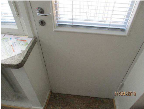
Kuva 85. Parvekeovet ovat alkuperäisiä, kaksilehtisiä ja lasiaukollisia puuovia.
