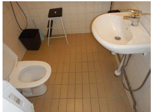
Kuva 126. Yleiskuva välipohjan lattialaattapäällysteestä kylpyhuoneesta A103.
