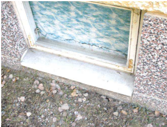
Kuva 48. Paikoin maanpinta on hyvin lähellä ikkunoiden alareunoja. Ikkunoiden vesipellitusten kallistukset ovat vähäisiä ja pellitysten liitokset seiniin ovat epätiivitä.
