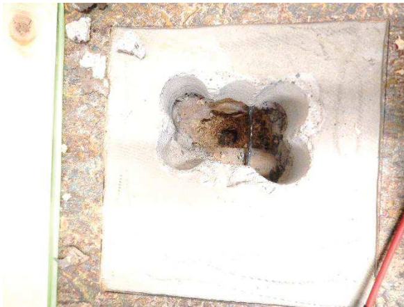
Kuva 28. Alapohja on kotelolaattarakenteinen ja ryömintätilallinen.
