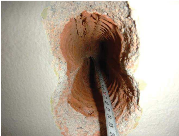
Kuva 108. Ulkoseinä on massiivitiilirakenteinen. Seinärakenteessa ei havaittu erillistä lämmöneristekerrosta.
