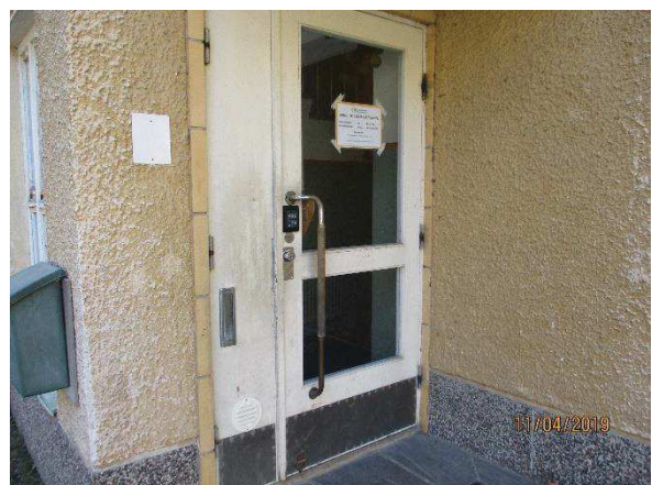
Kuva 84. Pääsisäänkäynnin ulko-ovi on alkuperäinen lasiaukollinen puuovi. Sisäänkäyntiovien yleiskunto on tyydyttävä. Ovien puurakenteissa on maalipinnoitevaurioita ja ovet ovat epätiivitä.
