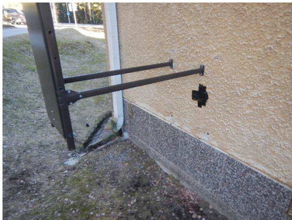
Kuva 92. Ulkoseinä on massiivitiilirakenteinen ja julkisivultaan rapattu sekä maalattu. Seinärakenteessa ei havaittu erillistä lämmöneristekerrosta. Rakenneavaus toteutettiin ulkokautta.
