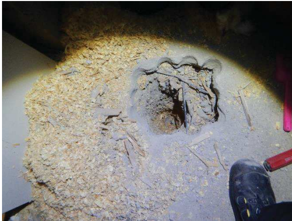
Kuva 191. Yläpohja on kotelolaattarakenteinen ja puueristeinen.
