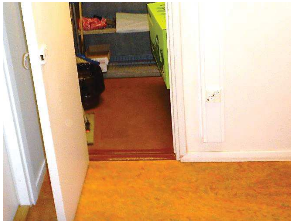
Kuva 125. Yleiskuva välipohjan linoleum- ja muovimattopäällysteistä eteistilassa A202 ja vaatehuoneessa A209.
