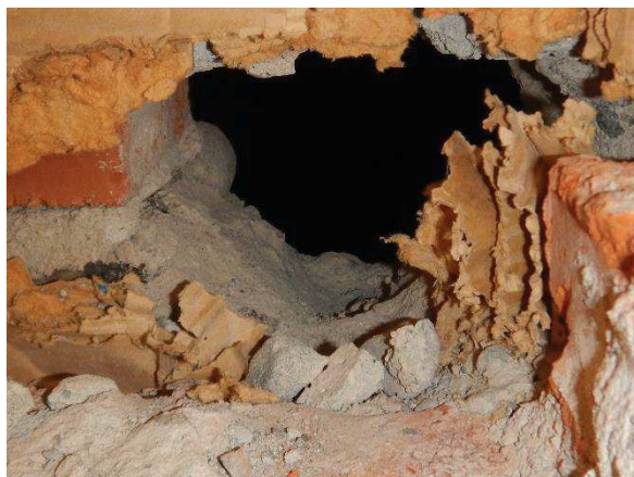
Kuva 164. Rakenneavauskohdan ympärillä ryömintätilaan rajoittuva väliseinä koostuu betonirakenteisesta ulkokuoresta, sisäpinnan bitumisivelestä, puukuitulevy- ja rakennuspahviversteistä sekä sisäkuorena olevasta tiilimuurauksesta.
