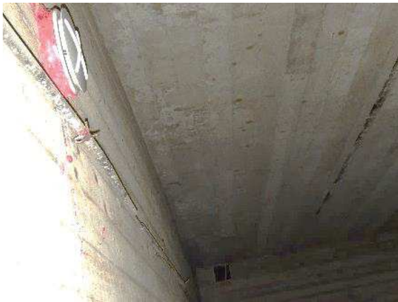
Kuva 16. Ryömintätilan tuuletus on toteutettu perusmuurissa sijaitsevien tuuletussäleikköjen avulla (kuvassa taustalla). Ryömintätilan vastaiseen seinään on lisätty ilmanvaihtoventtiili, joka on todennäköisesti liitetty rakennuksen alkuperäiseen painovoimaisen ilmanvaihdon kanavistoon.
