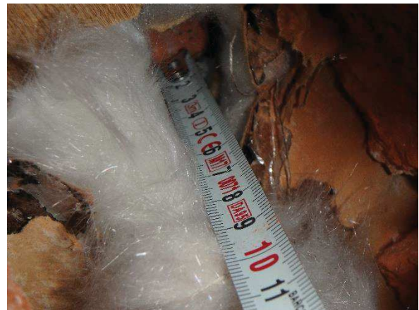
Kuva 95. Lämmöneristeenä on paperipäällysteinen lasivillaeriste.
