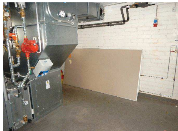
Kuva 3. Yleiskuva muovimattopäällysteisestä maanvaraisesta alapohjasta kellarin teknisestä tilasta A008.
