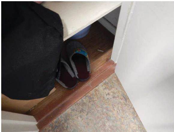
Kuva 8. Yleiskuva ryömintätalallisen alapohjan linoleum- ja muovimattopäällysteistä eteistilasta A111.
