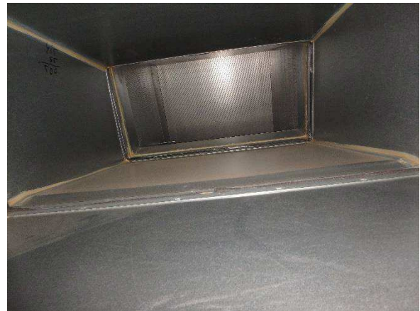
Kuva 215. Myös tuloilman runkokanava oli puhdas.
