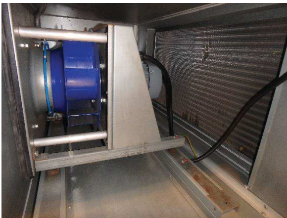
Kuva 206. Puhallinkammio ja puhaltimen siivet ovat puhtaita.
