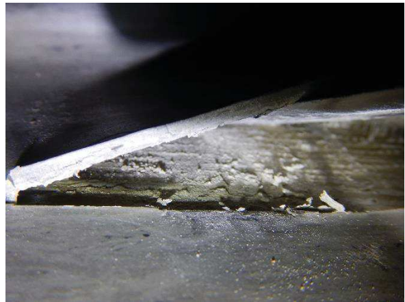
Kuva 34. Viiltomittaus VM2. Muovimaton kiinnitysliimassa ja lattiatasoiteessa ei havaittu aistinvaraisesti arvioituna viitteitä vaurioitumisesta.
