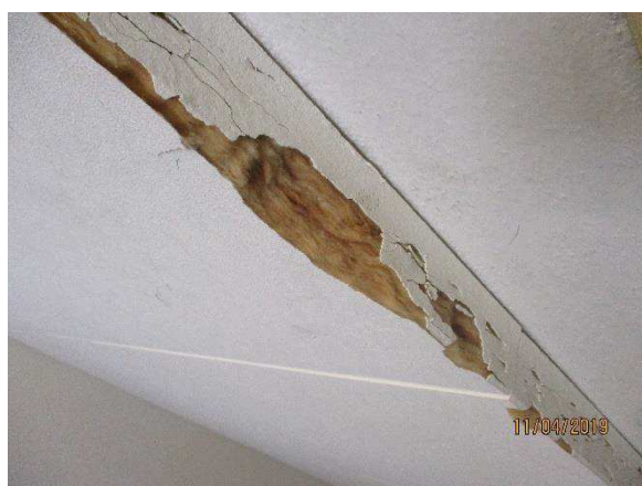
Kuva 220. Mineraalivillaa katon akustiikkalevyissä.
