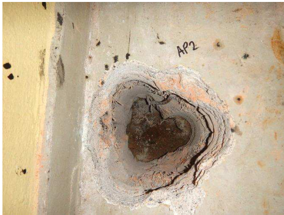
Kuva 22. Alapohjarakenteena on lämmöneristetty kaksoisbetonilaatta, jonka yläpinnassa on vedeneristetty pintabetonilaattarakenne. Maa-aines oli rakenneavauskohdalla kostea.
