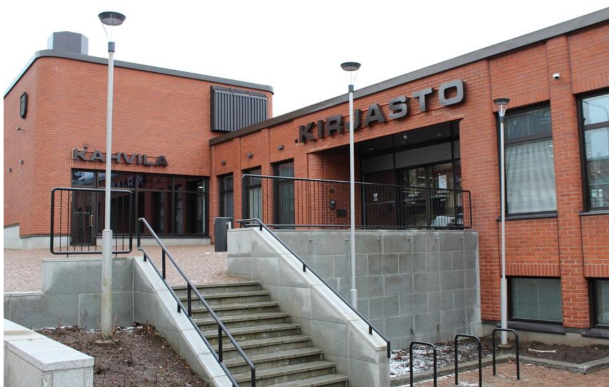
Hämeenlinnan kirjaston peruskorjauksen rakentamisvaihe jatkui koko vuoden 2019
