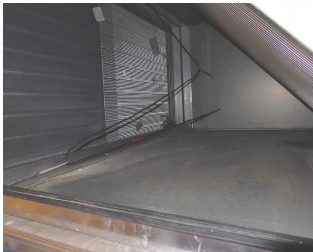
Kuva 33. Näkymiä tuloilmapuolelle. Vasemmalla on M6-tasoinen tuloilmasuodatin, jonka kehys oli tiivis. Oikealla levylämmöntalteenottolaitteen pohja ja lämmityspatterit.
