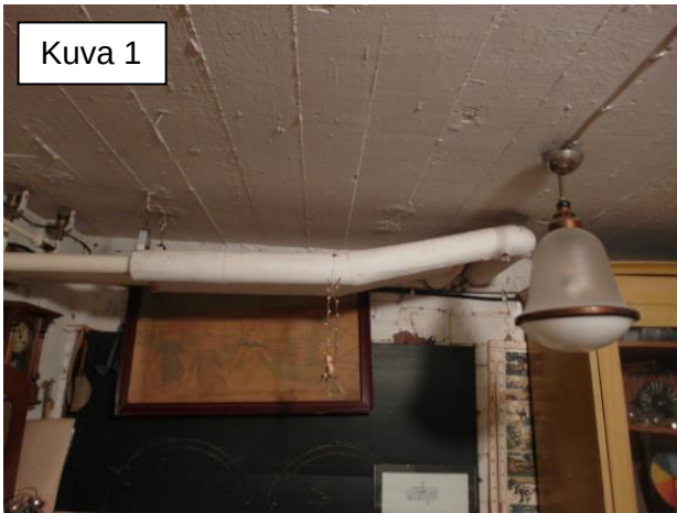
Kuvat 1-2. Vanhat putkieristeet sisältävät asbestia. Vanhoja putkieristeitä saattaa olla myös rakenteiden sisällä.
