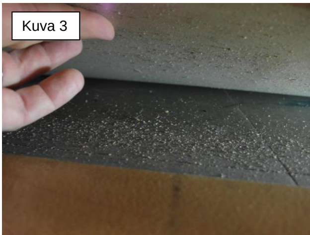
Kuvat 3-4. Vanhat vinyylilaatat ja musta liima sisältävät asbestia. Ne on juhla- ja voimistelusalissa jätetty uudempien pintamateriaalien alle.
