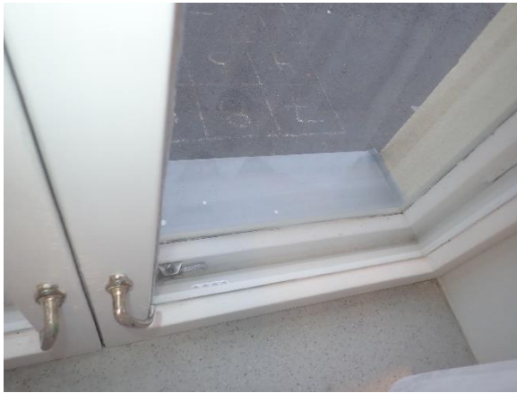
Kuva 12. Ikkunat alkuperäisiä, mutta huollettuja
