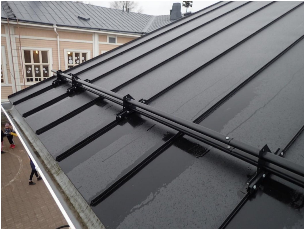
Kuvat 29 ja 30. Vesikatto ja sen turvavarusteet sekä sadevesikourut ja -syöksyt on uusittu vuonna 2015. Niiden kunnossa ei ollut huomautettavaa.
