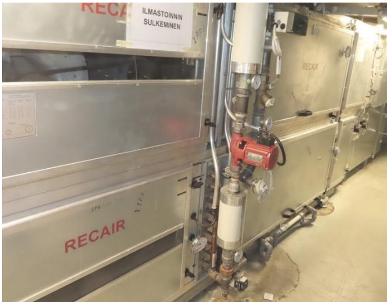
Kuva 32. Ilmanvaihtokone TK2.
