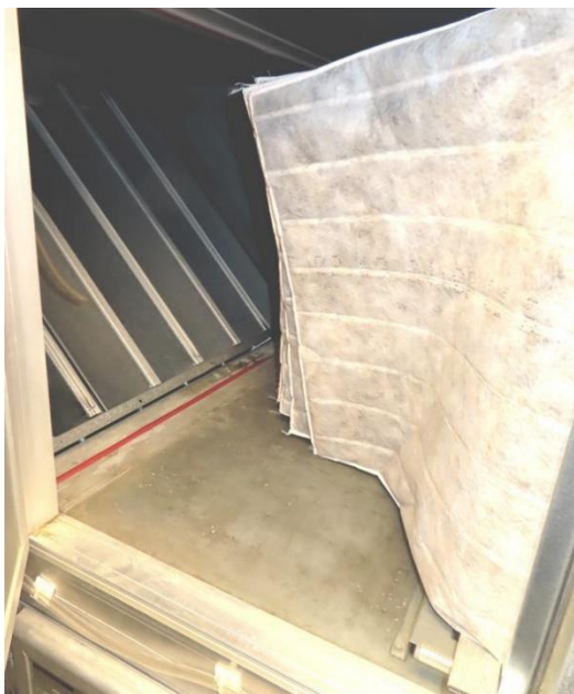
Kuva 33. Näkymiä tuloilmapuolelle. Vasemmalla on M6-tasoinen tuloilmasuodatin, jonka kehys oli tiivis. Oikealla levylämmöntalteenottolaitteen pohja ja lämmityspatterit.
