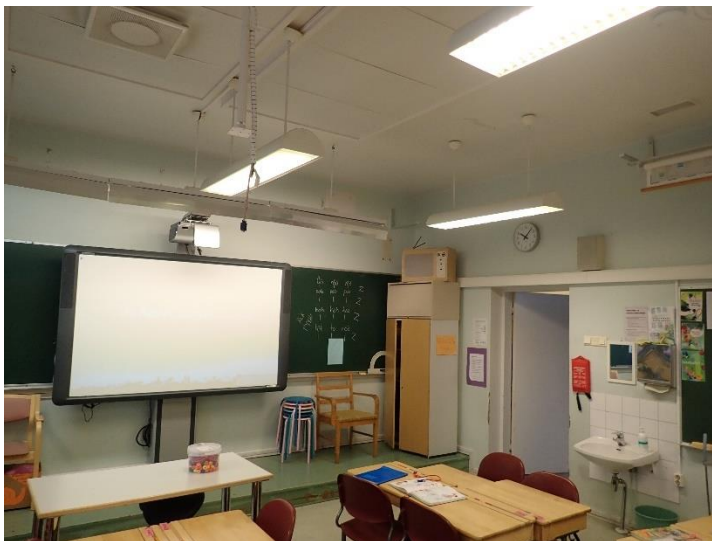
Kuva 31. Yläpohjan alalaatan alapintaan on tehty ripustuksia ja johdettu läpivientejä.
