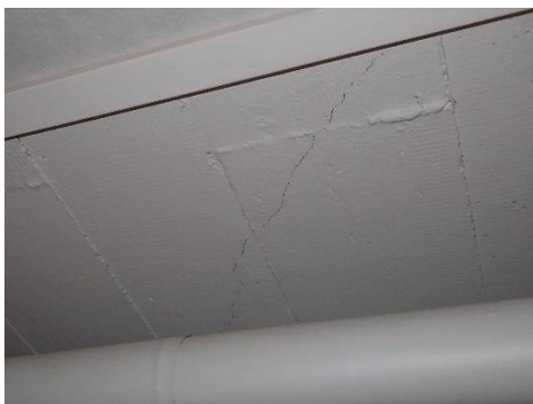
Kuva 22. Tilan K14 katto.
