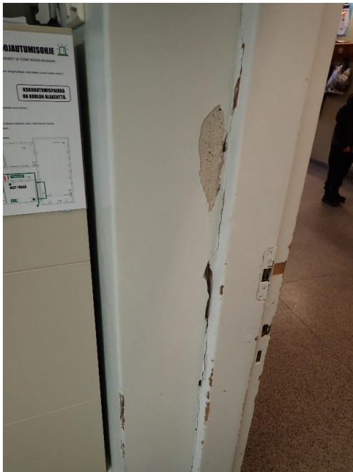
Kuva 13. Välioven pintavaurioita.
