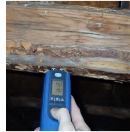
Kattopalkissa kosteus puupiikkimittarilla 14 -p.%
