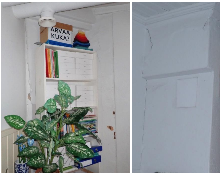
Kuvat 21 ja 22. Väliseinässä havaittiin isoja halkeamia kaakeliuunin toisella puolella sekä monitoimitilassa hormin kohdalla pinnan kupruilua sekä halkeamia.
