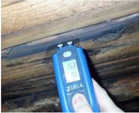
Ruodelautojen kosteus puupiikkimittarilla 15-18 -p.%
