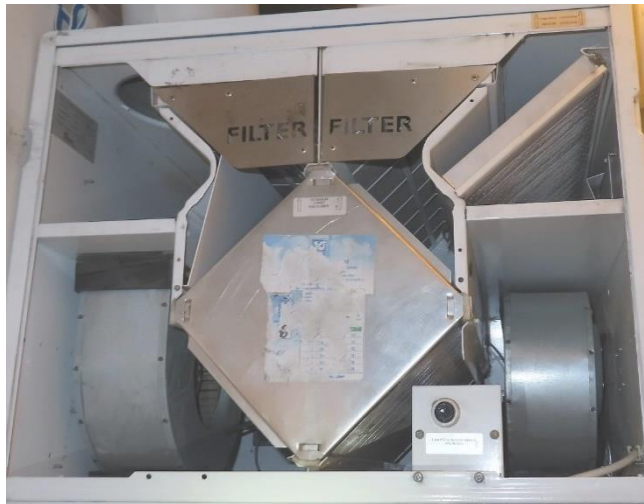
Kuva 32. Ilmanvaihtokone Vallox 130 E. Oikealla näkymä koneen sisään.
