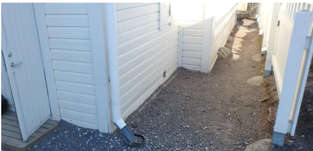
Kuvat 7, 8 ja 9. Rakennus on perustettu luonnonkivien varaan. Luonnonkivien välejä on betonoitu. Julkisivulla, joka on kuistien välillä, on betonisokkelia.
