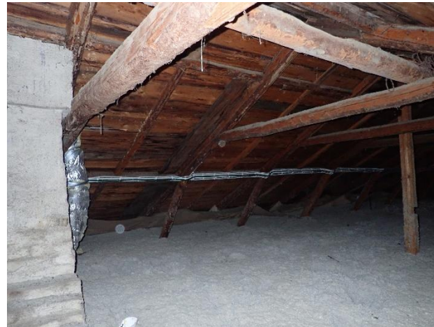
Ruodelaudoissa ja piipussa kosteusjälkiä ja piipun rappaus on rapistunut. Vesikatteessa ei havaittu aluskatetta.
