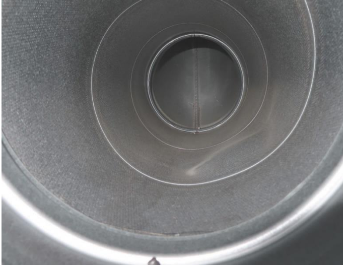
Kuva 34. Monitoimiovetustilan tuloilmakanava, jonka sisäpinnan pölykertymäarvio oli alle 1 \text{ g/m}^2 (arviointipiste KP1).
