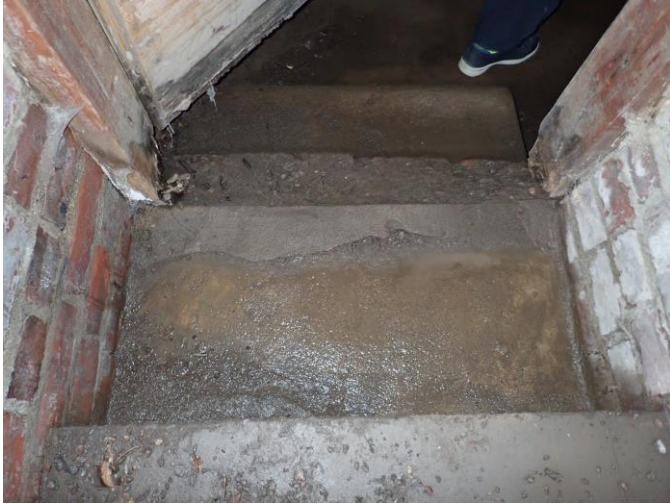
Sisäänkäynnin oven karmit ovat vaurioituneet.
