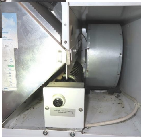
Kuva 33. Ylhäällä tuloilman esisuodatin ja poistoilmasuodatin, joihin oli kertynyt paljon epäpuhtauksia/pölyä. Oikealla näkymä tuloilmapuolelle lämmöntalteenottolaitteen jälkeen, jossa oli näkyvää pölyä kotelon pohjalla.
