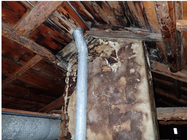
Ruodelaudoissa ja piipussa kosteusjälkiä ja piipun rappaus on rapistunut. Vesikatteessa ei havaittu aluskatetta.
