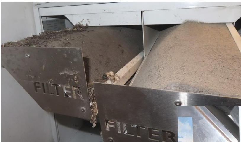
Kuva 33. Ylhäällä tuloilman esisuodatin ja poistoilmasuodatin, joihin oli kertynyt paljon epäpuhtauksia/pölyä. Oikealla näkymä tuloilmapuolelle lämmöntalteenottolaitteen jälkeen, jossa oli näkyvää pölyä kotelon pohjalla.
