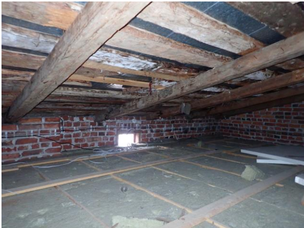
Vesikatossa ei ole aluskatetta. Ruodelaudoissa havaittavissa kosteusjälkiä.
