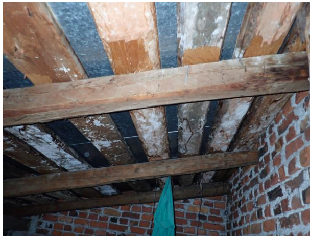
Vesikatossa ei ole aluskatetta. Ruodelaudoissa havaittavissa kosteusjälkiä.
