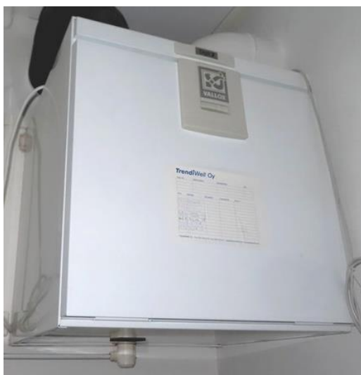
Kuva 15. Ilmanvaihtokone Vallox Digit2 SE. Oikealla näkymä koneen sisään.
