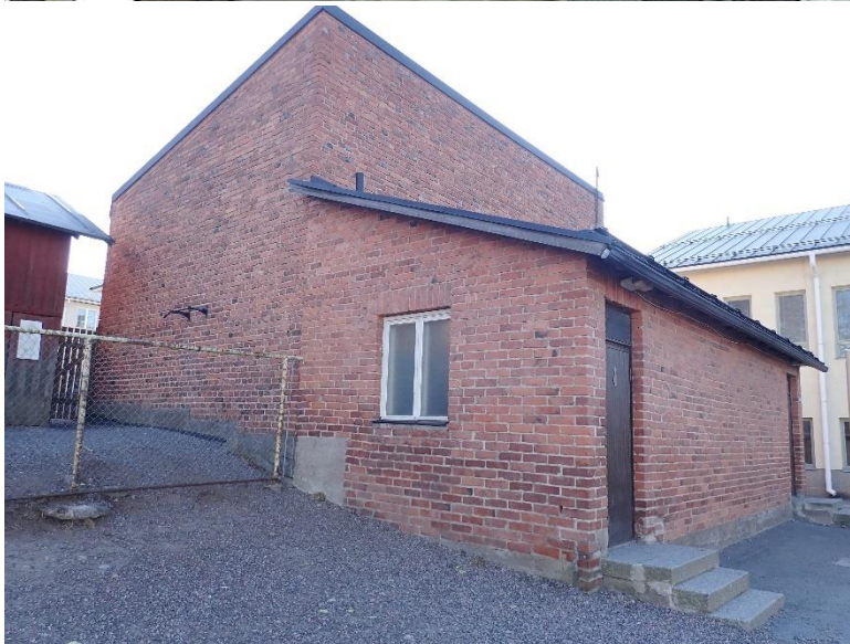
Kuvat 1 ja 2. Ilmakuva, maps.google.fi ja julkisivukuva
