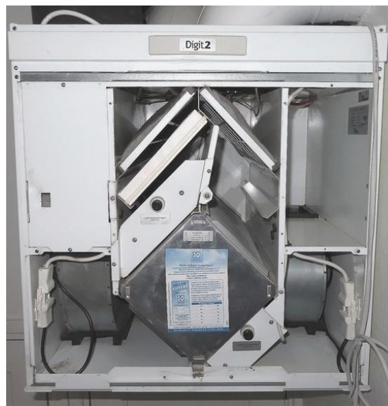
Kuva 15. Ilmanvaihtokone Vallox Digit2 SE. Oikealla näkymä koneen sisään.
