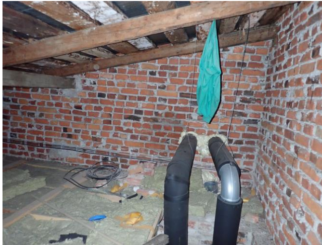
Ullakkotilassa näkyvillä mineraalivillaa
