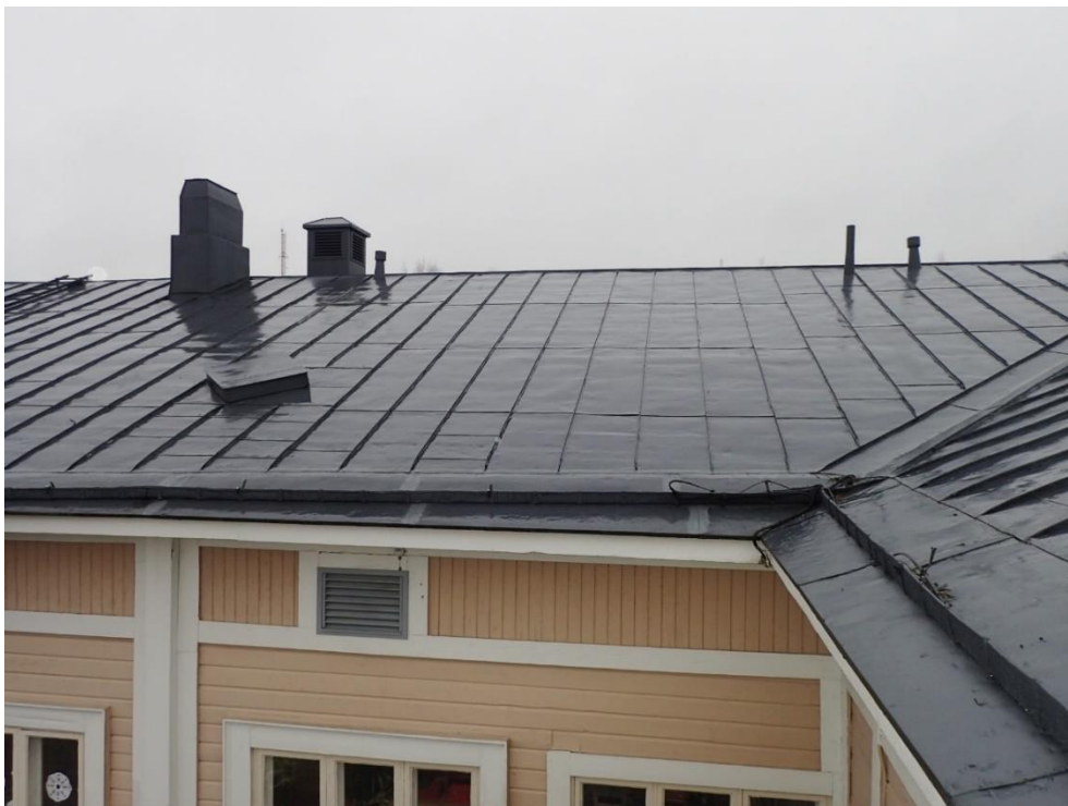
Kuva 28. Sadevesikourussa on lämmityskaapeli. Rakennuksessa ei ole lumiesteitä.
