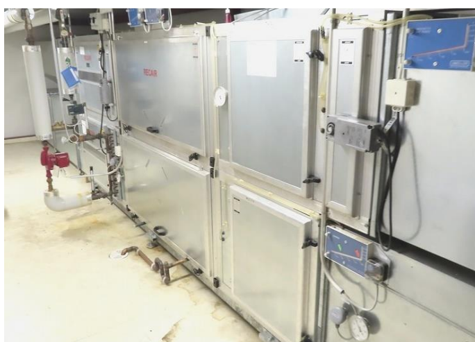
Kuva 29. Ilmanvaihtokone TK1.
