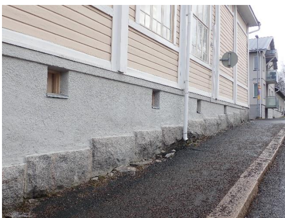
Kuvat 8 ja 9. Alustatilan tuuletusaukkoja on peitetty koneellisen ilmanvaihdon lisäämisen jälkeen.
