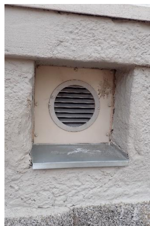
Kuvat 8 ja 9. Alustatilan tuuletusaukkoja on peitetty koneellisen ilmanvaihdon lisäämisen jälkeen.
