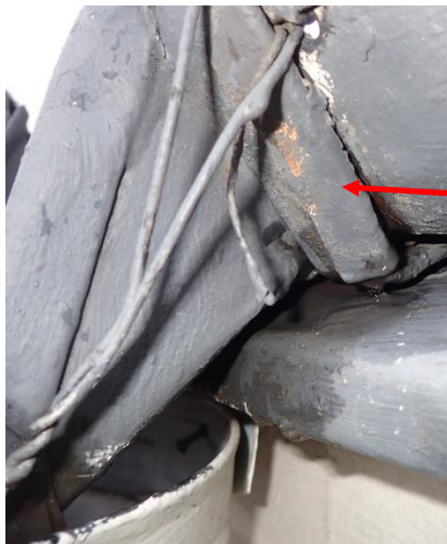
Kuvat 25 ja 26. Sadevesisyöksyjen yläosien kiinnitykset sadevesikouruun.
