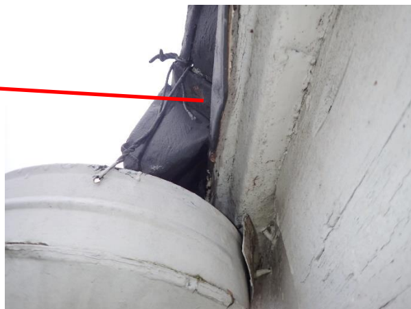
Kuvat 25 ja 26. Sadevesisyöksyjen yläosien kiinnitykset sadevesikouruun.
