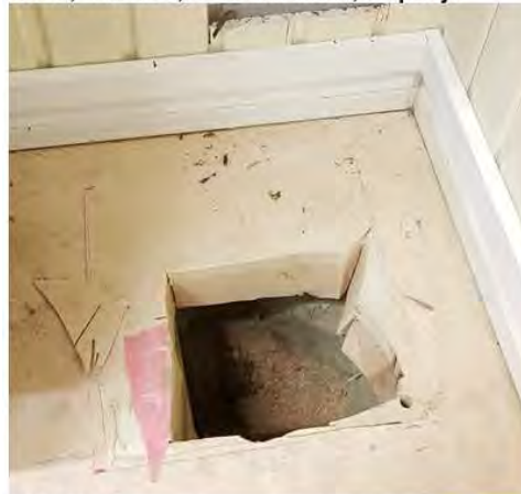
RA47, 1-kerros, huoneen lattia, alapohja
