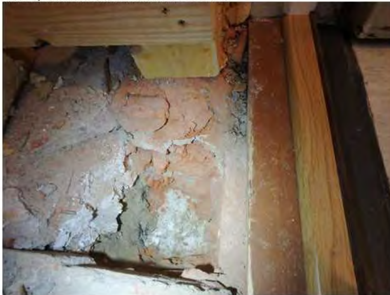
RA 57, lattia ullakon oviaukon kohdalla
