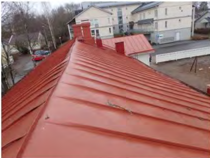
Kuva 24. Kattopelti on maalattu ja maalipinta on kunnossa. Vesikatolta puuttuvat kattoturvatuotteet.
