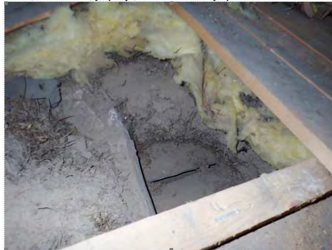
RA40 , ullakko U01, yläpohja, siivoustilan 107 yläpuolella
