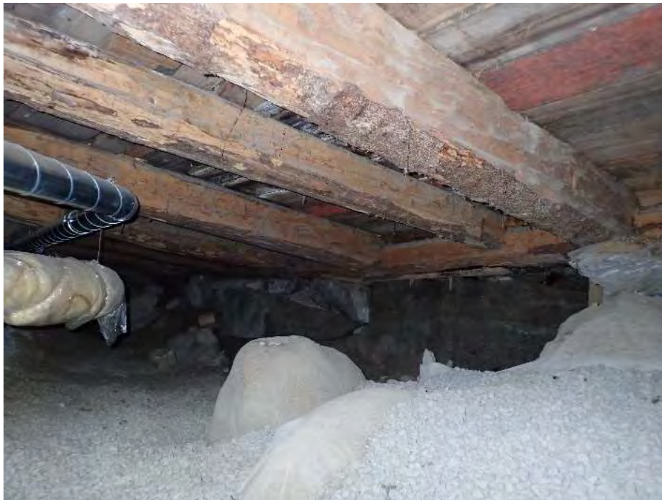
Kuva 6. Tuulettuvan alapohjan alapinnan laudoituksessa on tummentumia, mutta aluslaudoitus on nykyään kuiva. Luonnonkiviperustuksissa ei todettu sortumia.
