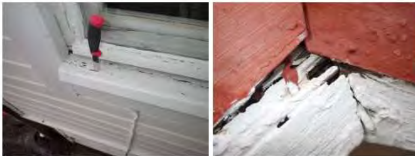
Kuva 17. Ikkunoiden vaakalaudat ja räystäiden otsalaudat ovat pehmenneet kosteuden vaikutuksesta.
