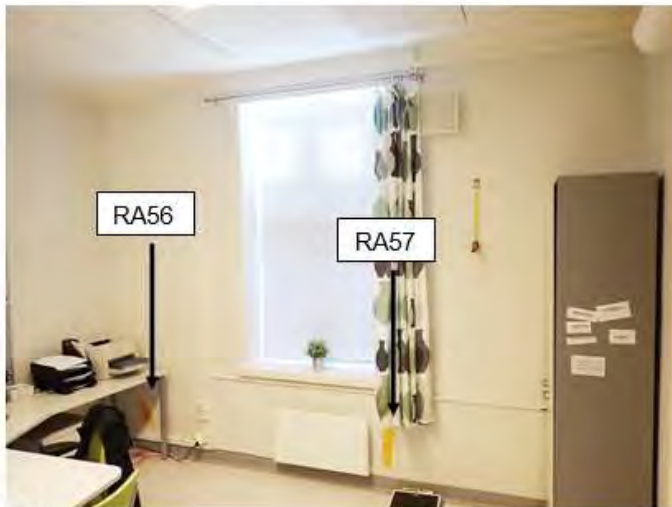
RA 55 ja RA56, Terveystilojen ulkoseinä
