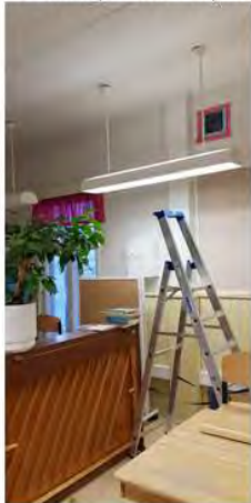
RA46 a , 1-kerros, monitoimiopetustilan ulkoseinän yläosa, sisäkautta tehty avaus
