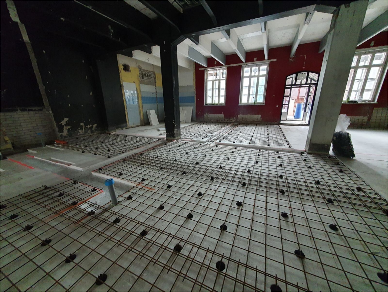
1.krs matalan osan alapohjan raudotusta
