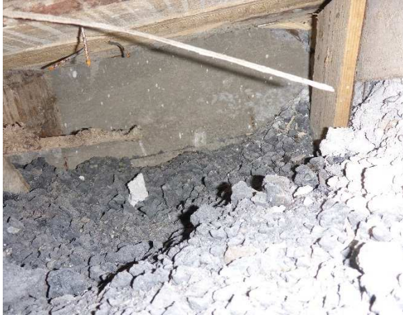
Kuva 24. Alalaattapalkiston eristetilassa on käytetty D-siivessä koksikuinaa. Yläkannen puurakenteiden kunto on vaihtelevaa
