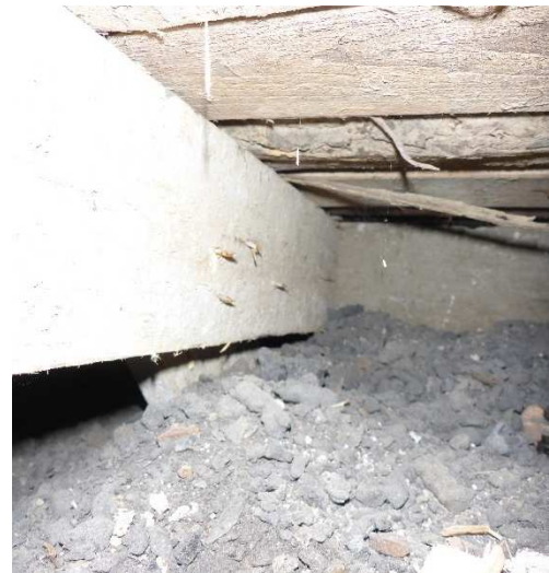
Kuva 27. Välipohjan eristetilassa on muurausjätteen lisäksi kaikki muottilaudat paikallaan
