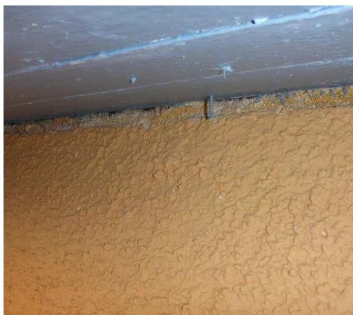
Kuva 28. E-siiven tuuletusrako räystäällä on lähes ummessa. Tästä syystä ilma ei kierrä yläpohjassa kunnolla
