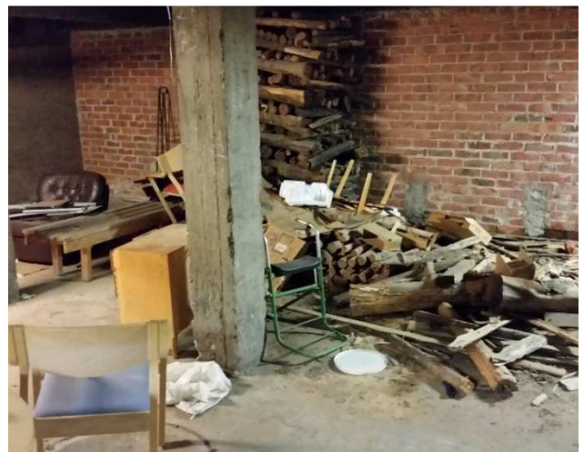
Kuva 11. Vanhoja polttopuita sekä muuta romua on kellarissa säilytyksessä. Huoneesta on suora ilmayhteys hissikuilun avulla ylempiin kerroksiin.
