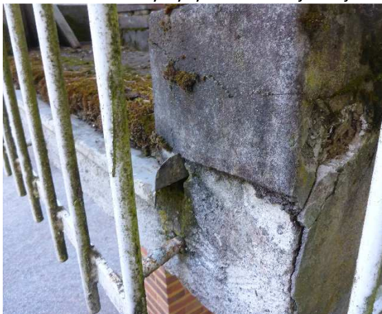
Kuva 22. Parvekettä kannattelevan holvin ja seinämäisen palkin pinoilla on pakkasrapautumaa
