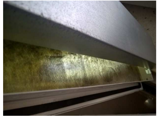
Kuva y. Tuloilmaventtiilin äänenvaimennuksena on lasikuituharsolla päällystettyä mineraalivillaa.
