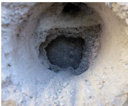
Kuva 20. Rappauksen takana oleva kevytbetoniharkko on kunnoltaan ehjä ja hyvä.
