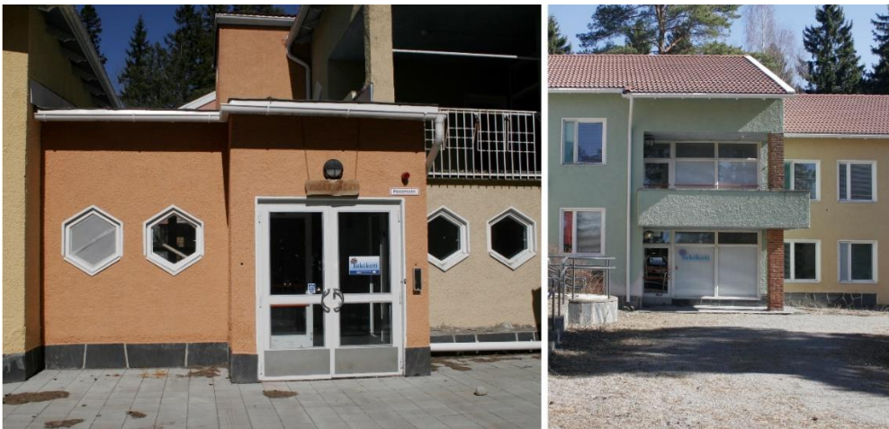
KUVA: Vanhainkodin sisäänkäynti ja siipirakennuksen julkisivua keväällä 2019
