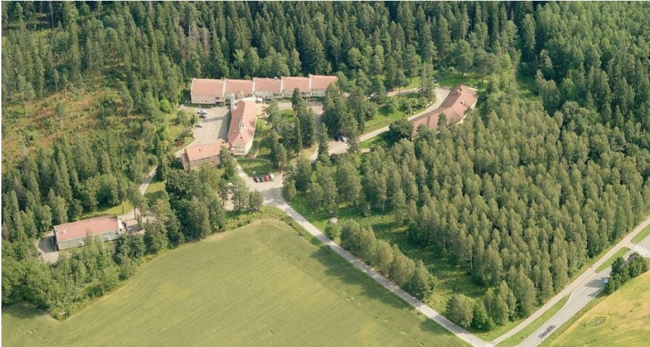
KUVA: entisen Vuorentaan vanhainkodin rakennuksia suunnittelualueella.
