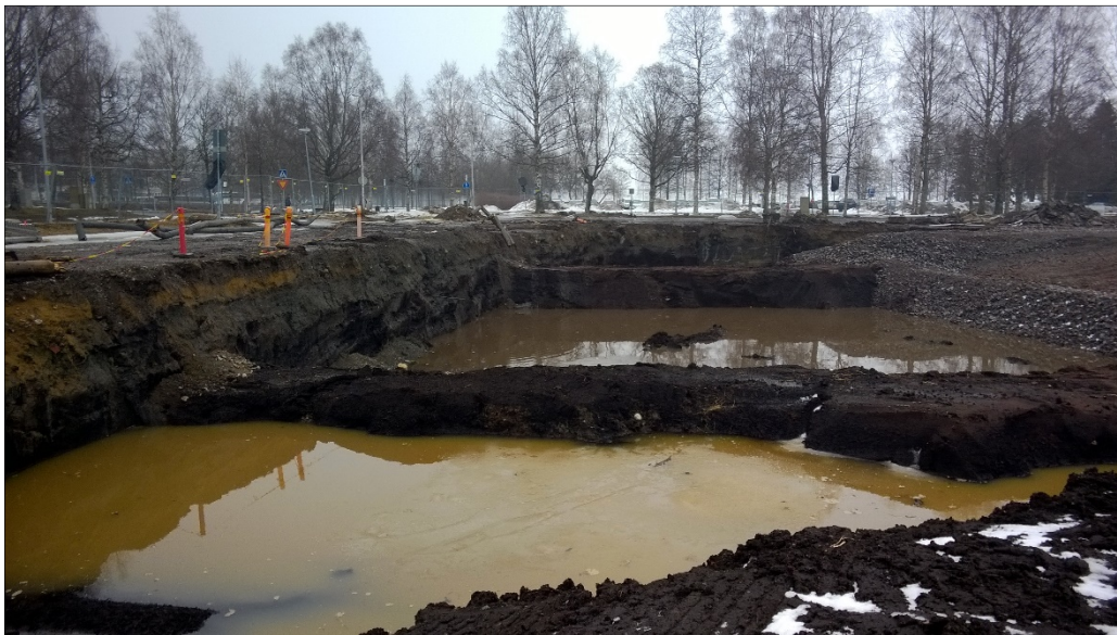
Kuva 12. Entisen Hämeenkaaren tontin pohjoispuolen kaivanto.
