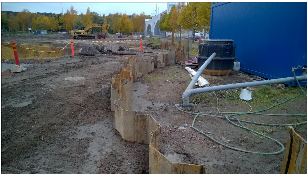
Kuva 8. Kaivantovettä pumpattiin HS-veden viemäriin.
