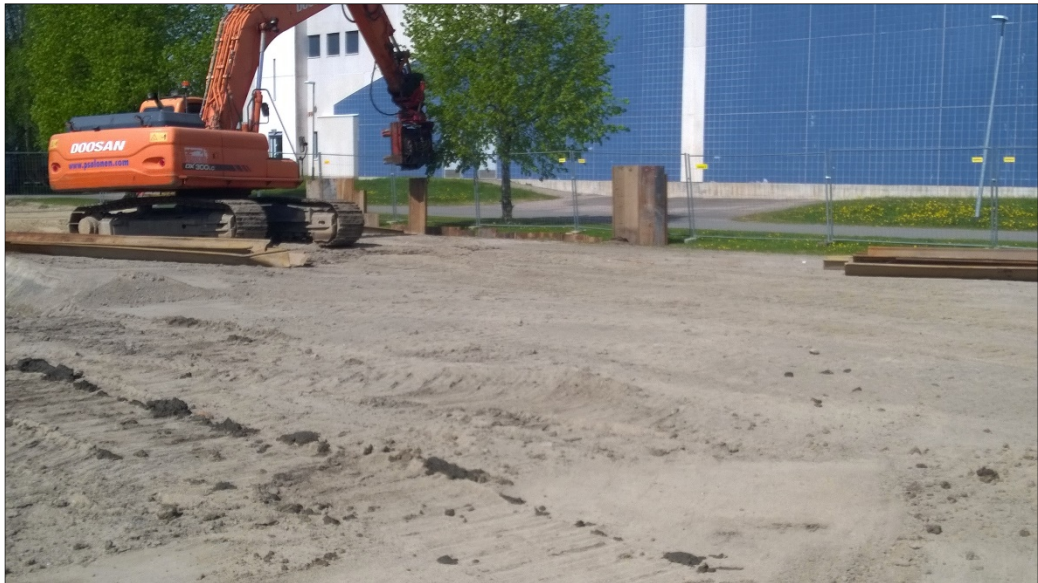
Kuva 5. Asuinalueen kaivannon seinämät jouduttiin tukemaan ponttiseinillä.
