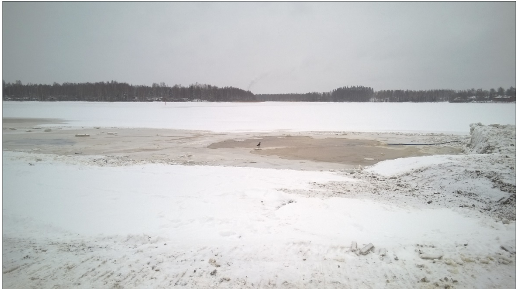
Kuva 9. Uimarannan edustaa jäädytettiin ruoppauksen jälkeen uuden hiekan asentamista varten.
