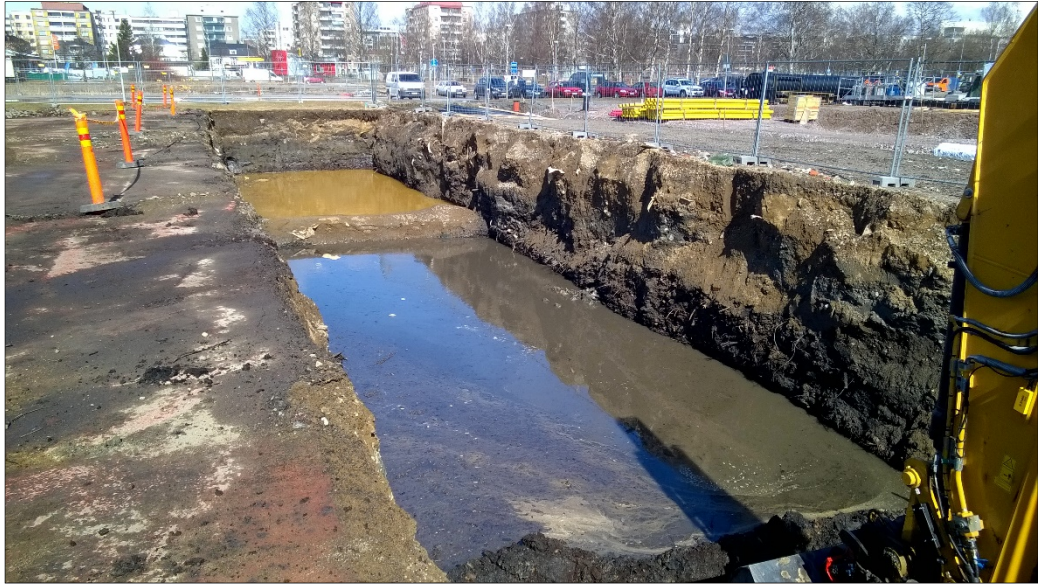
Kuva 1. Uimahallin vastainen kaivu asuinalueella.
