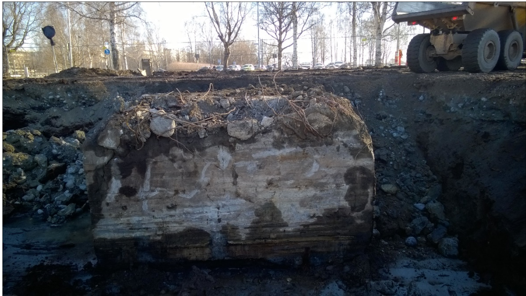
Kuva 13. Entisen Hämeenkaaren tontilta löytyi maanalaisia betonirakenteita.
