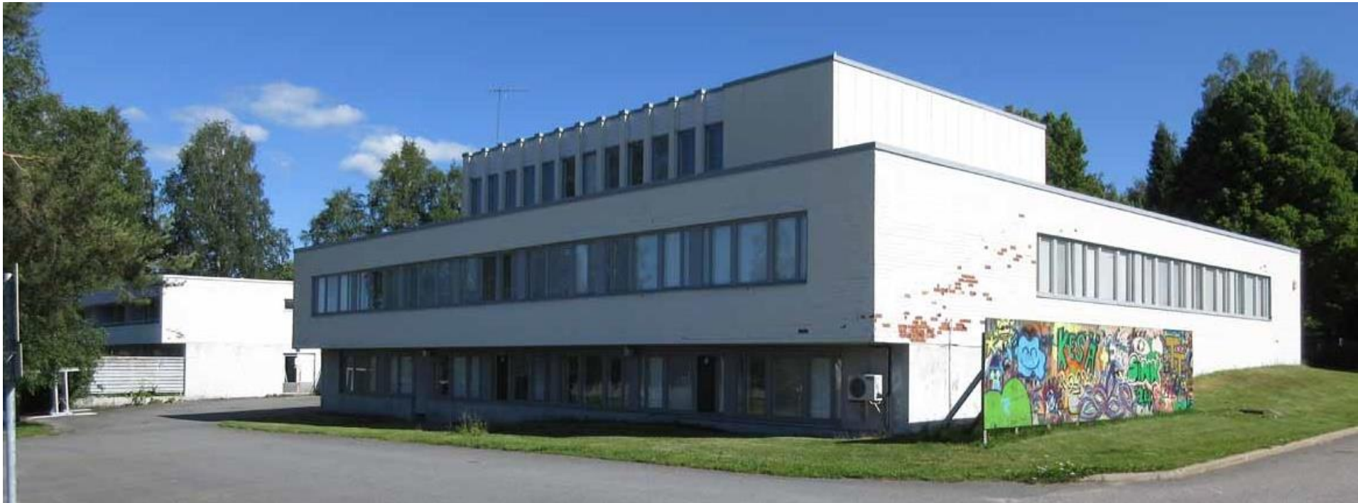
Kuvat: Ylhäällä kunnantalo ja sen asuntolan pihajulkisivua. Oikealla rakennuksia yhdistävä ja rinteeseen upotettu autotalliosa.
