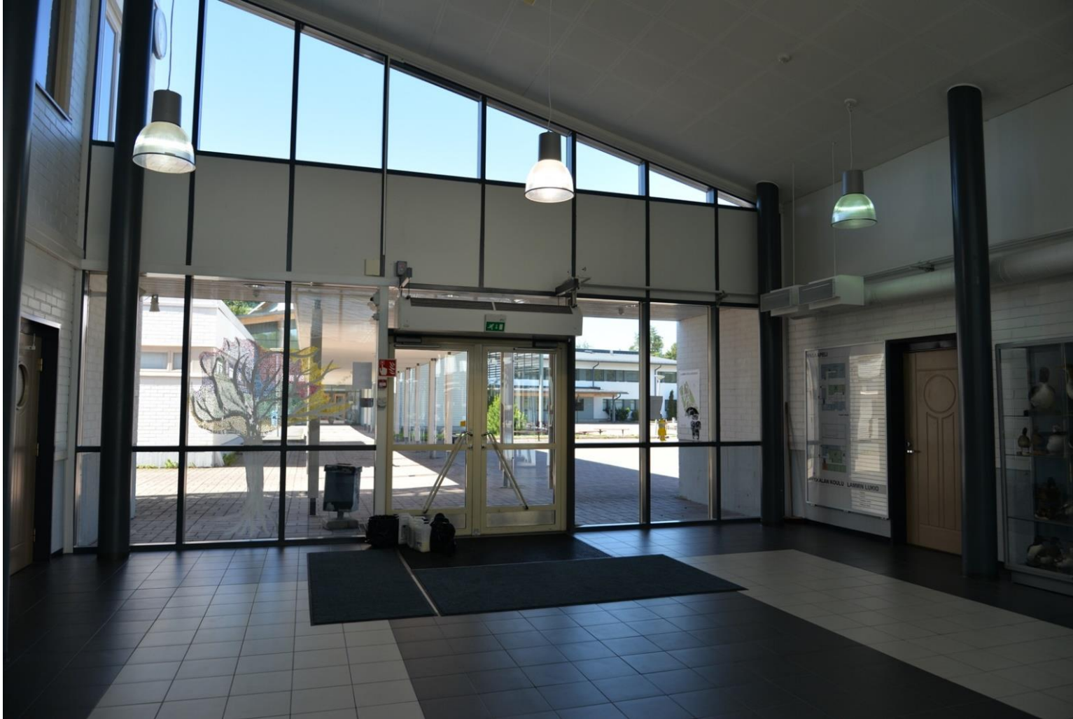
Kuva: Uusi pääaula muodostui kun A ja B osa yhdistettiin lasikatoksella ja Hakkalan koulu yhdistettiin Pasaapelin kouluun katoksella.
