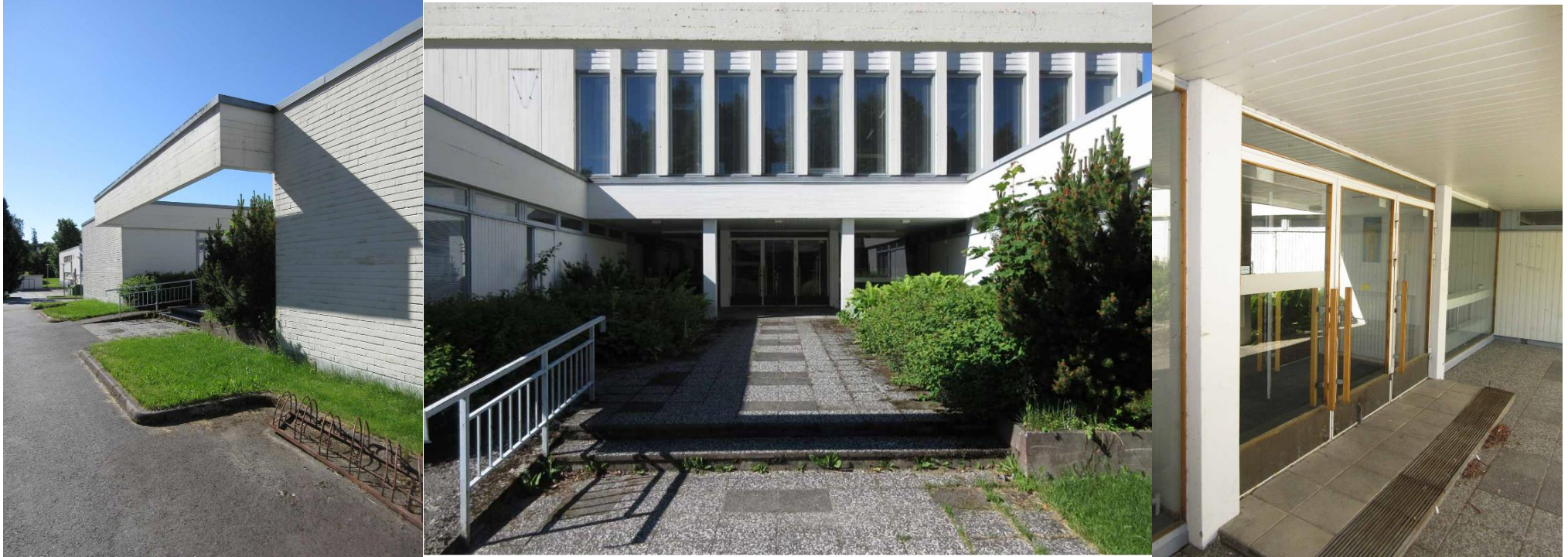
Kuvat: Sisäänkäyntiä ja pihaa hallitsevat betonipinnat laattoina ja seinäpintaa kiertävänä betonipalkkina. Sisäänkäynti on sijoitettu valtuustosalin alle.
