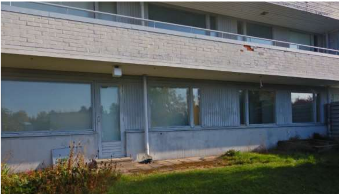
Kuva 12. Asuntolan alarinteen puoleisessa ulkoseinässä on kohdekäynnin perusteella mahdollisesti puurunkoista ulkoseinää. Kellarikerroksen ikkunoiden alapuolella julkisivuna betoniseinä ja ikkunoiden välissä julkisivulaudoitus.
