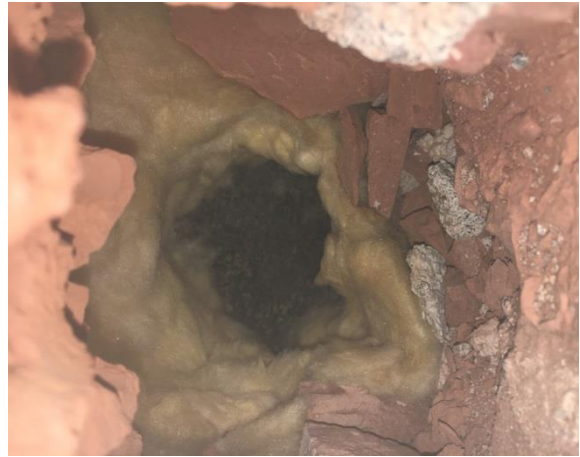
Kuva 15. US1 rakenneavaus luokassa 118. Valesokkelin sisäpinnalla bitumisively.
