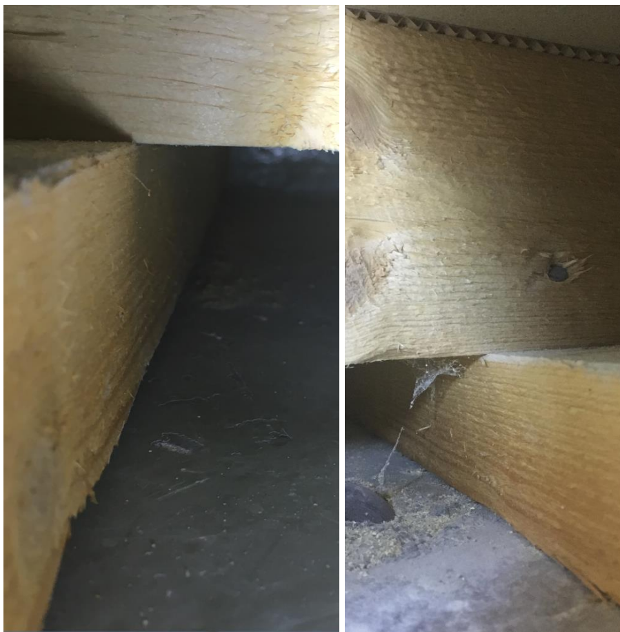
Kuvat 5 ja 6. Puukorokelattia opettajan työtilassa 310 rakennettu vanhan muovimaton päälle (vasemmalla). Portaikko rakennettu aulassa 101c betonilattian päällä (oikealla). Puurakenteissa ei havaittu kosteuden aiheuttamia jälkiä tai poikkeavaa hajua.
