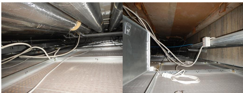
Kuvat 50 ja 51. Pukeutumistilan 102 kattolevyjen yläpuolinen tila (vasemmalla) ja käytävän 102c kattolevyjen yläpuolinen tila (oikealla).
