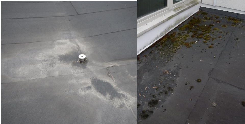
Kuva 24. Vesikate oli silmämääräisesti tarkastettuna siisti ja ehjä. Huopakatteen pinnalle kertynyt sammal suositellaan poistettavan.
