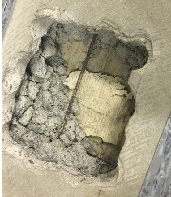
Kuva 9. Rakenneavaus 3 käytävällä (VP2)
