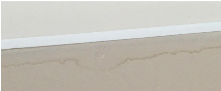
Kuva 21. Vanhoja kosteuden aiheuttamia jälkiä kangastaulussa
