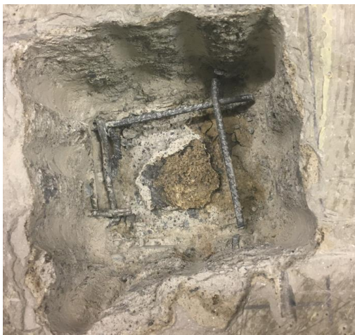
Kuva 4. AP2 rakenneavaus tilassa 106. Tilassa ollut aiemmin kylmiö. Alapohjan kevytsorabetonin päällä bitumisively.
