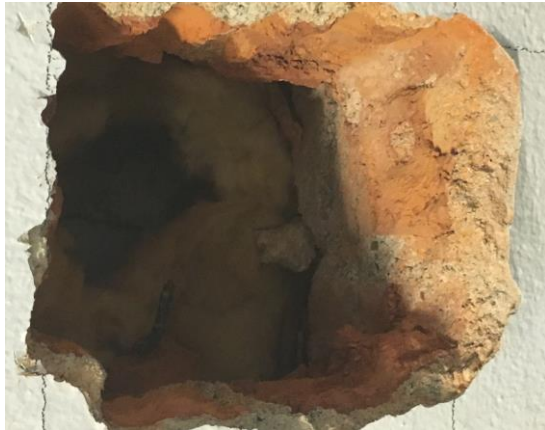
Kuvat 16 ja 17. Rakenneavaus 2 tilassa 206 (US2). Ulkoseinätiilen sisäpinnalla ei ole bitumisivelyä.
