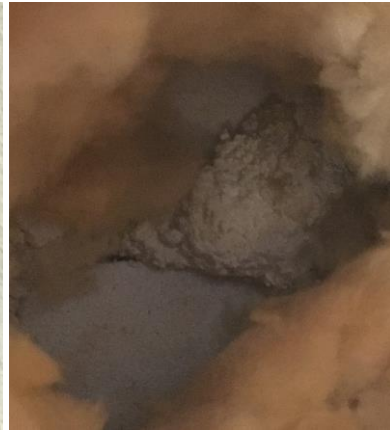
Kuvat 16 ja 17. Rakenneavaus 2 tilassa 206 (US2). Ulkoseinätiilen sisäpinnalla ei ole bitumisivelyä.
