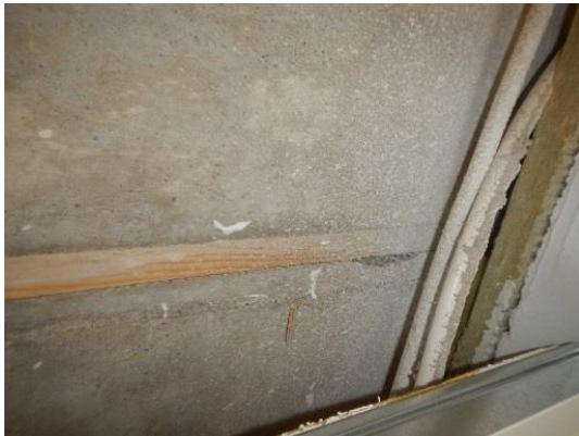
Kuva 13. Välipohjan muottilaudoitusta tilassa 114.
