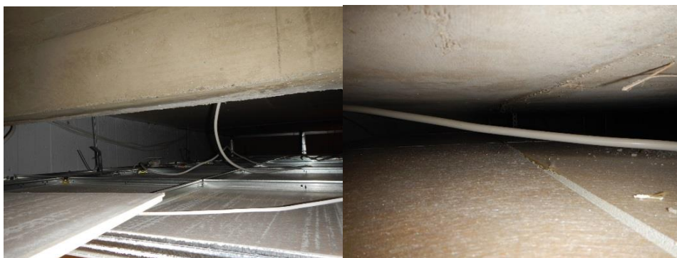
Kuvat 52 ja 53. Vaateaulan 101a kattolevyjen yläpuolinen tila (vasemmalla) ja kotitalousluokan 114 kattolevyjen yläpuolinen tila (oikealla).
