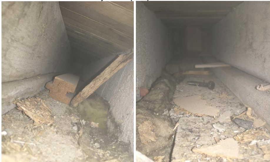
Kuvat 10 ja 11. VP3 välipohjatyypin. Rakenne tarkastettiin välinevarastossa 220.
