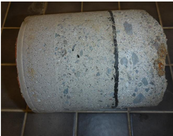
Kuva 4. Pesutilan 010 alapohjarakenne on vastaava kuin käytävätiloissa. Syynä eroavaisuuteen on se, ettei tila ole alun perin ollut pesuhuone.
