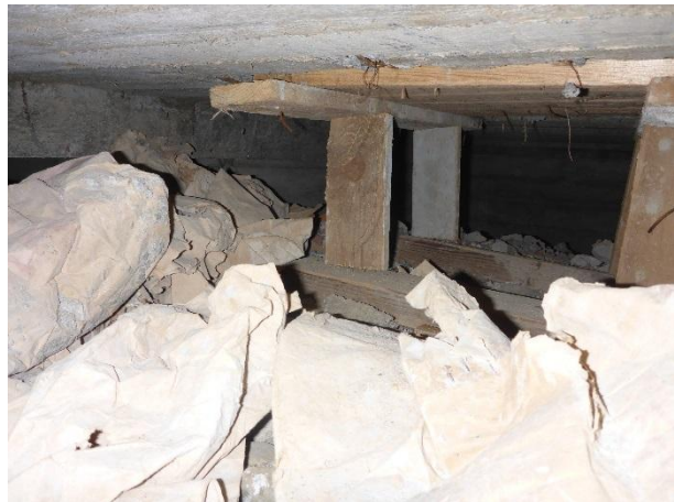
Kuva 9. ontelotilassa on rakennusjätteiden lisäksi vanhat muottituet paikallaan
