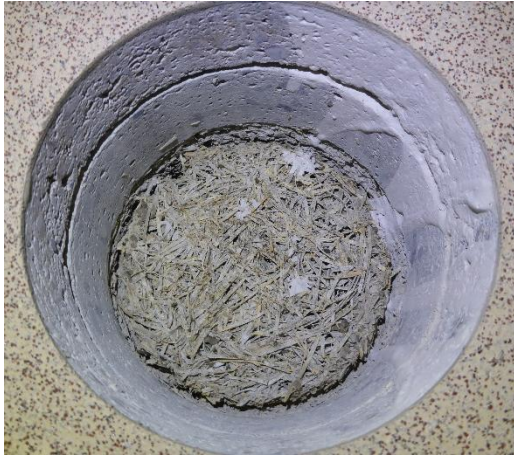
Kuva 6. Pukuhuoneiden kohdalla on alapohja lämmöneristetty betonirakenteiden väliin asennetulla lastusementtilevyllä.
