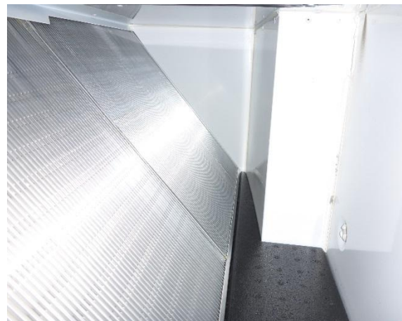
Kuva 39. LTO-kennot (2kpl) ovat puhtaat ja kammion pohjalla ei ole pölykertymää
