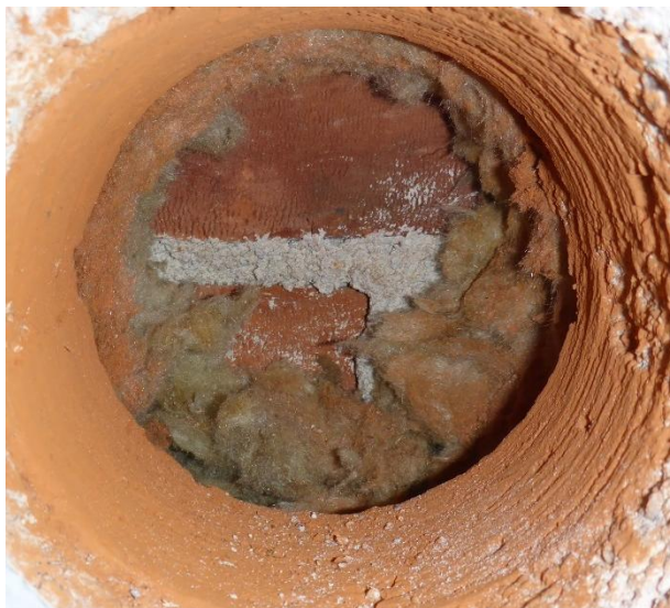
Kuva 21. Tiili-villa-tiili ulkoseinärakenne
