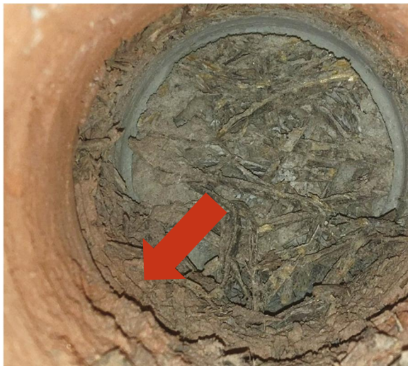
Kuva 17. Ulko seinältä tasauspalkin taakse porattu reikä.
