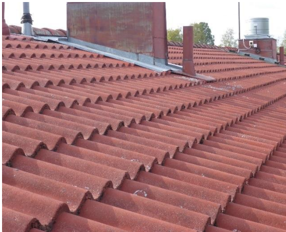
Kuva 32. Vesikatteen kunto on hyvä. Vain yksittäisiä tiiliä on rikkoutunut.
