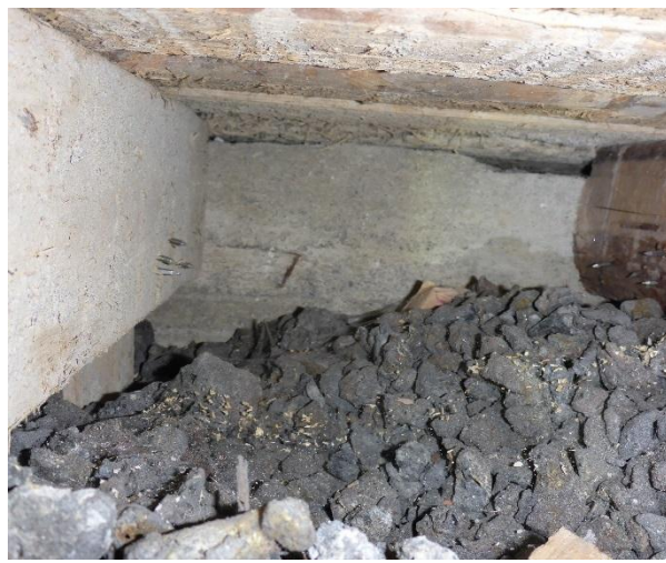
Kuva 25. Koksikuonalla täytetty VP-3 tyyppin välipohjarakenne
