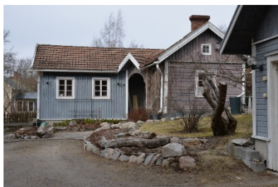
Kuvat 14-16. Vanhat talousrakennukset ovat yleensä hirsi- tai rankarakenteisia tai molempia. Rakennukset ovat puuverhottuja tai paljaalla hirrellä.
