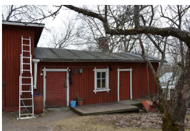
Kuvat 14-16. Vanhat talousrakennukset ovat yleensä hirsi- tai rankarakenteisia tai molempia. Rakennukset ovat puuverhottuja tai paljaalla hirrellä.
