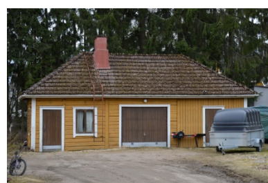
Kuvat 14-16. Vanhat talousrakennukset ovat yleensä hirsi- tai rankarakenteisia tai molempia. Rakennukset ovat puuverhottuja tai paljaalla hirrellä.
