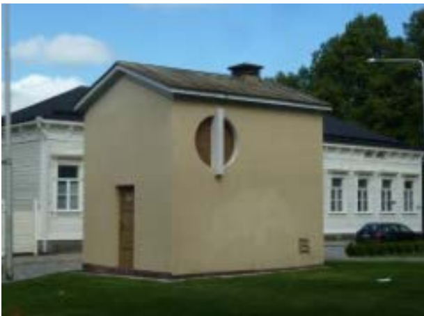
Kuva 21. Muuntamorakennus, joka on valmistunut vuonna 1937.
