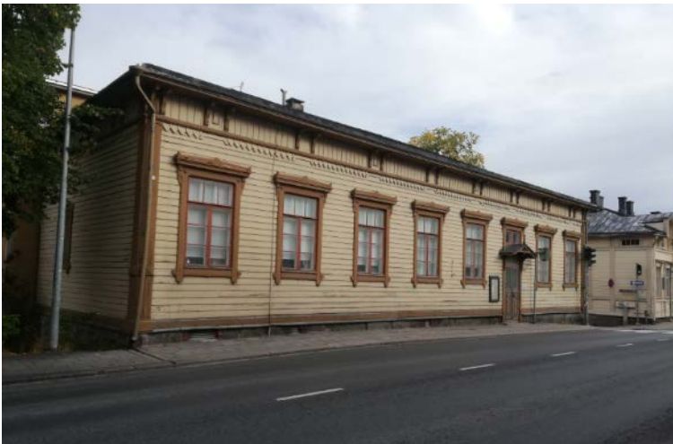
Kuva 3. Gaddin talon puinen yksikerroksinen osuus, rakennettu 1877-1881.
