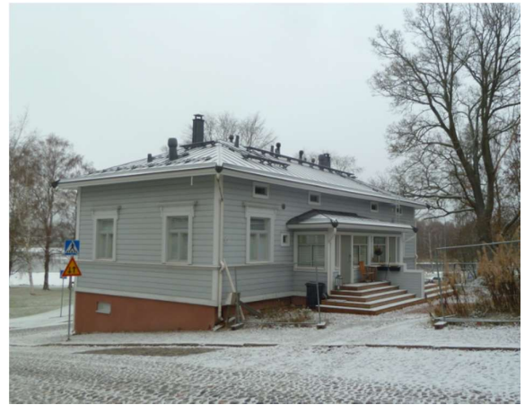
Kuva 10. 2010-luvulla valmistunut paritalo.
