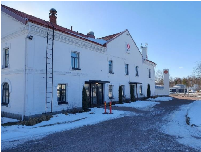
Kuva 25. Lasitehtaan konttorirakennus (kuva 03/2021).
