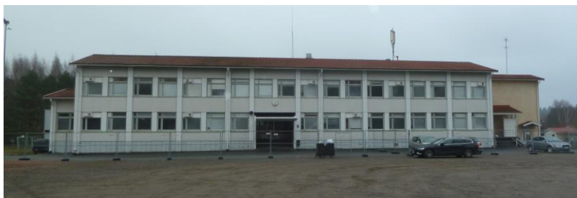
Kuva 7: Vuorentaan koulun julkisivu Marssitien suunnasta.
