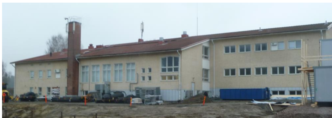
Kuva 8: Vuorentaan koulun takajulkisivu.
