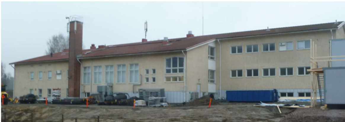
Vuorentaan koulun takajulkisivu.
