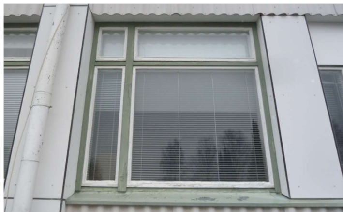
Koulun mineriitti-julkisivua ja tyyppi-ikkuna, jotka ovat säilyneet alkuperäisinä.
