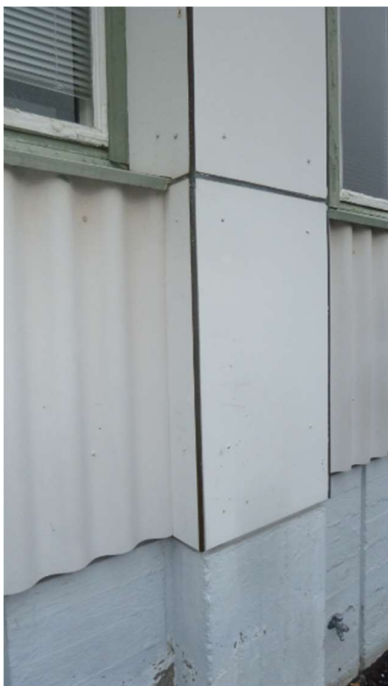
Koulun mineriitti-julkisivua ja tyyppi-ikkuna, jotka ovat säilyneet alkuperäisinä.
