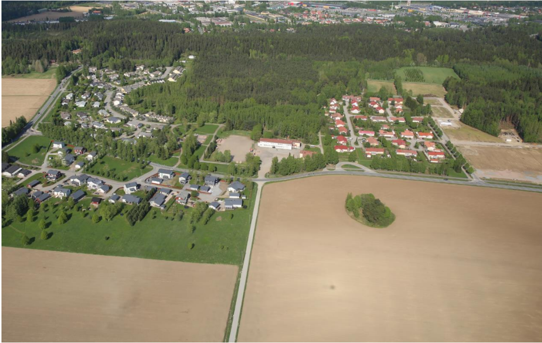
Kuva 5: Puuistutukset rajaavat koulun pihaa. Vuorentaan koulu sijoittuu pientaloalueiden väliin. Ilmakuva on vuodelta 2018.
