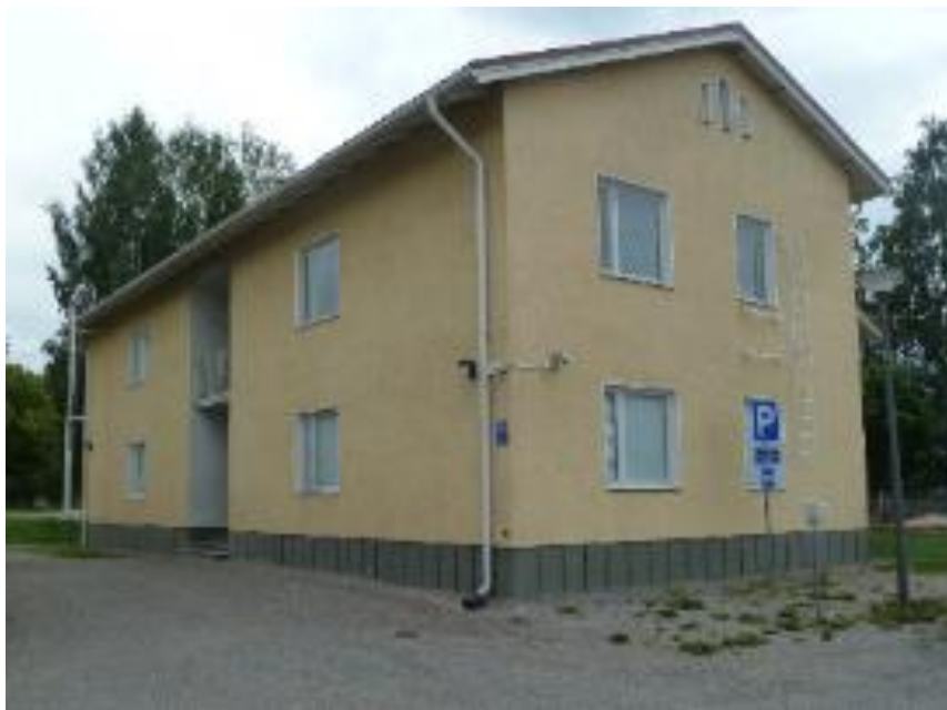
Kuva 10: Asuinrakennuksen itäpääty ja pohjoisjulkisivua.
