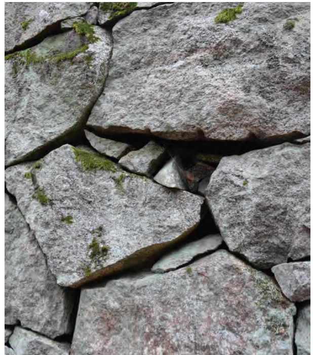
Pienten täytekivien rykelmä korvataan yhdellä isolla.
