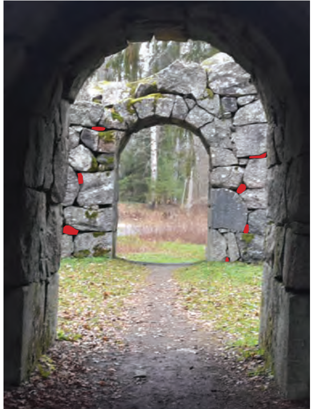
Vasemmalla ajoittamaton historiakuva HäKM. Oikealla nykytilannekuva, johon merkitty puuttuvat täyteki- vet.
