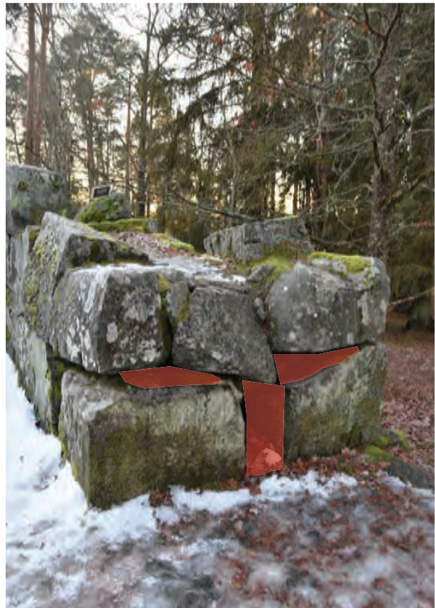
6.1 Tätekiven lisääminen hankaloittaa kiipeämistä, kun jalalle ei ole enää porrasta.
