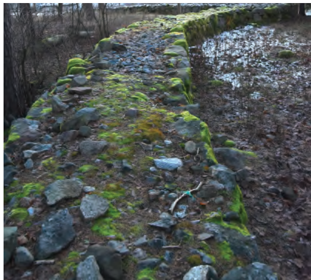
Alueen kiviaidat on tehty myös kylmämuurirakenteisina.
