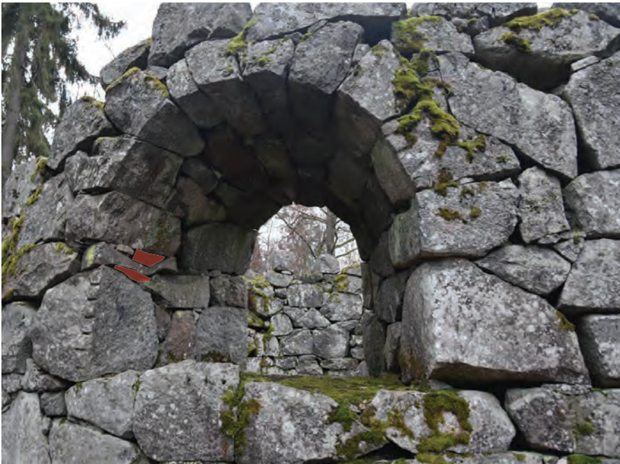
4.1 Holvin kantaan lisätään täytekiviä.
