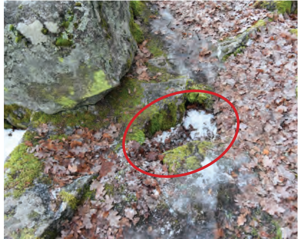
3.1 Vettä keräävä kolo täytetään kivillä ja vesieristeenä toimivaa laastia täydennetään.
