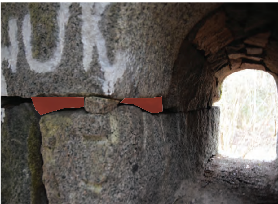
4.2 Holvin kanta lepää pienen kiilakiven päällä. Viereen lisätään molemmille puolille täytekiviä.
