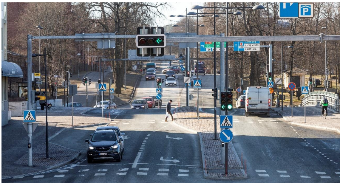
Kuva 30 Liikennettä Turuntien sillalla
