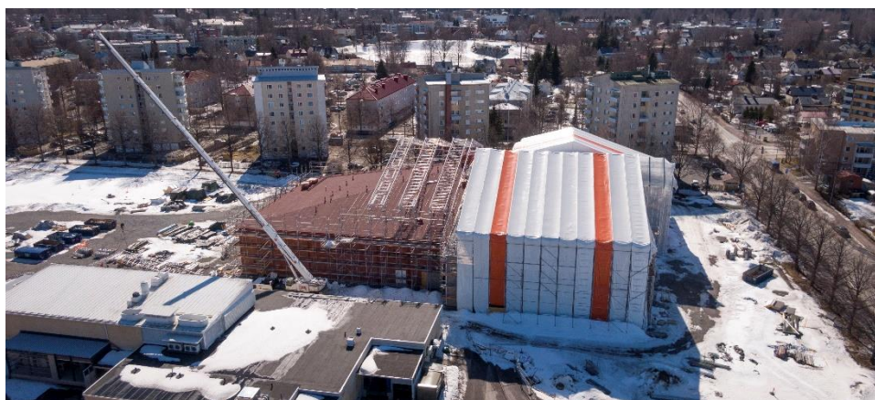
Kuva 21 Kaurialan koulun työmaa
