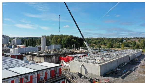
Kuva 13 Paroisten jätevedenpuhdistamon saneeraus, HS-Vesi
