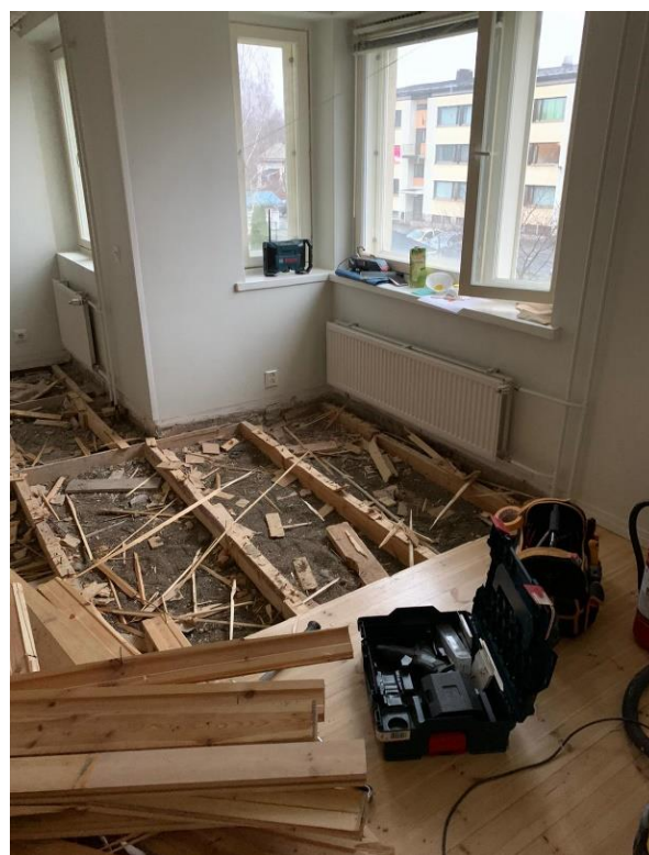
Kuva 12 Parolantie 19 remontti, kuva: Tuomas Mikkola
