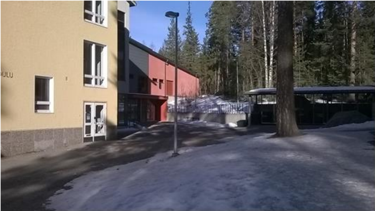
Koulun laajennus valmistui pohjoispuolelle v. 2011.
