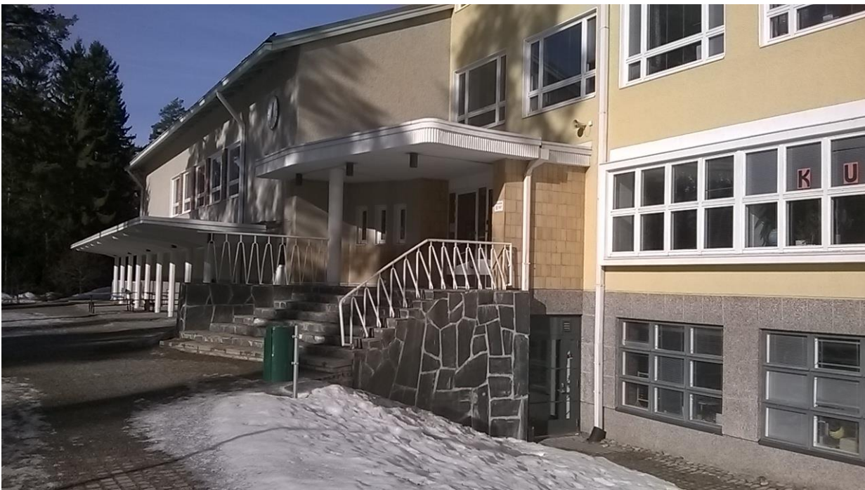
Pääsisäänkäynnin portaat ja kaiteet sekä alkuperäiset betoniset katokset.
